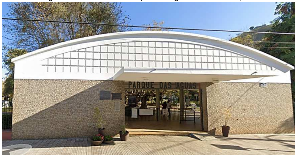
Figura 7 — Entrada do Parque das Águas de Caxambu, MG.
