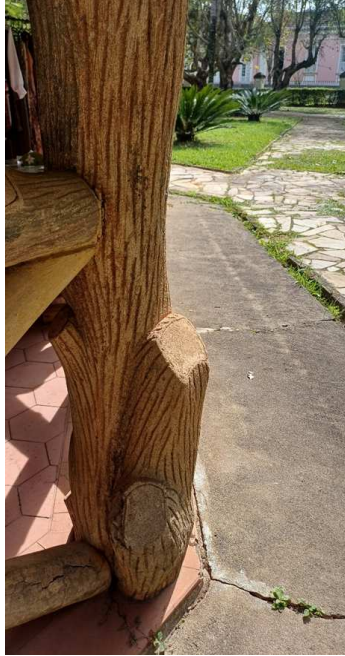
Figura 32 — Imitação de troncos de árvores no Quiosque, obra de Chico Cascateiro.
