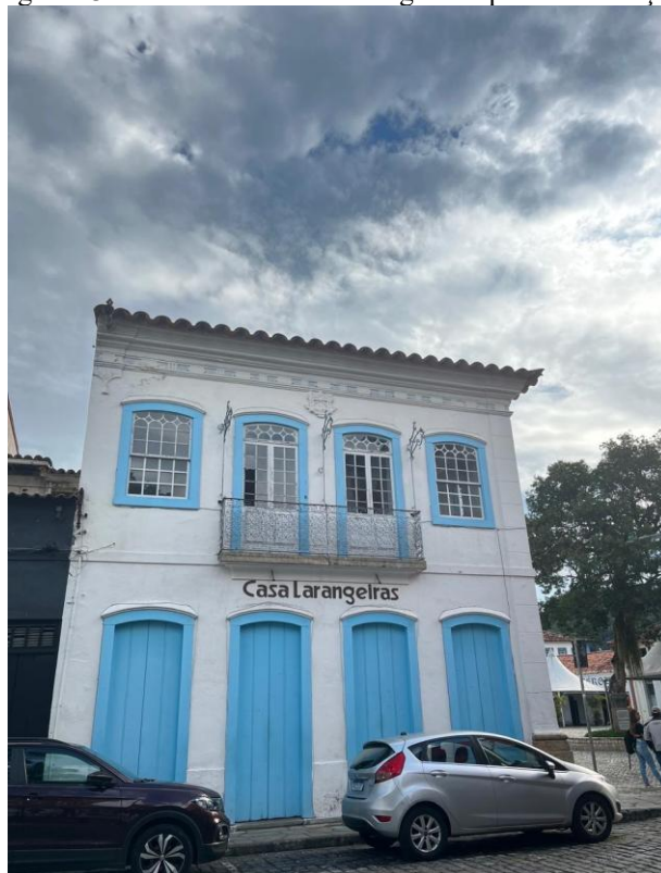
Figura 13 - Fachada da Casa Laranjeiras após revitalização
