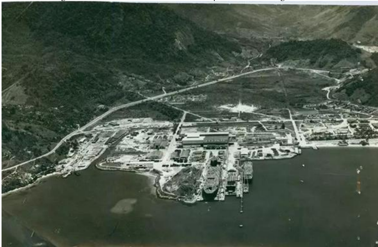
Figura 2 - Vista aérea do Estaleiro Verolme e da planície da Jacuecanga em 1975.
