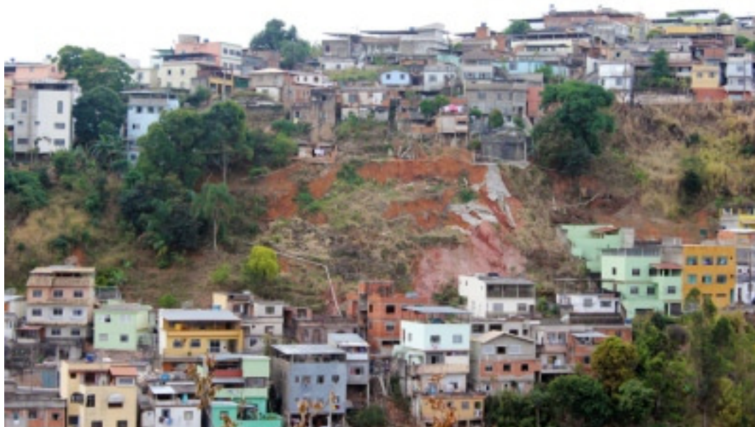
Figura 56 – Imagem do escorregamento da rua Rosa Sfeir – Bairro Grajaú (VALENTE, 2011)
