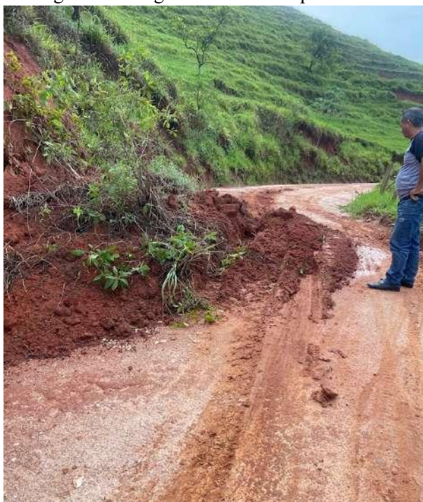
Figura 42 - Registro da estrada após a chuva
