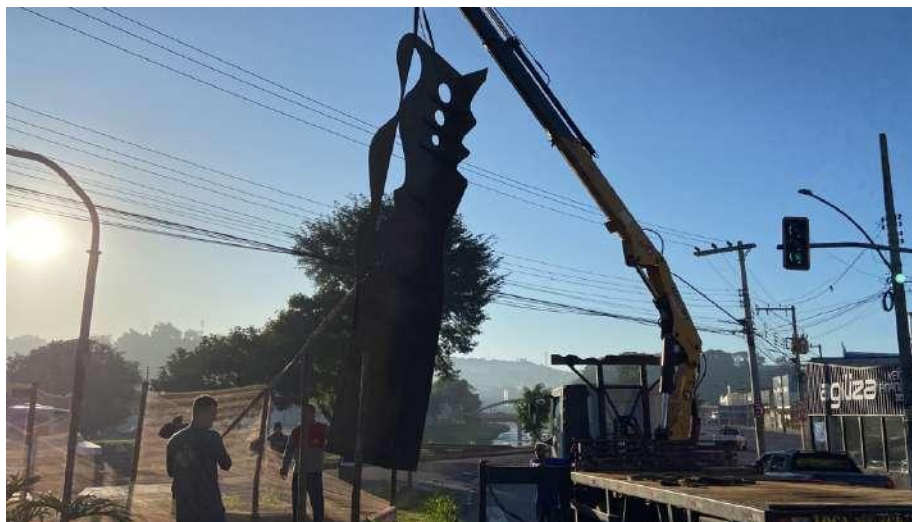
Figura 34 — Processo de soldagem do Monumento à 4ª adutora de água tratada de Juiz e Fora
