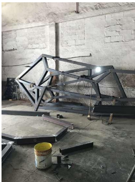
Figura 13 — Módulo previamente soldado, preso na parede do galpão, enquanto outro módulo é montado
