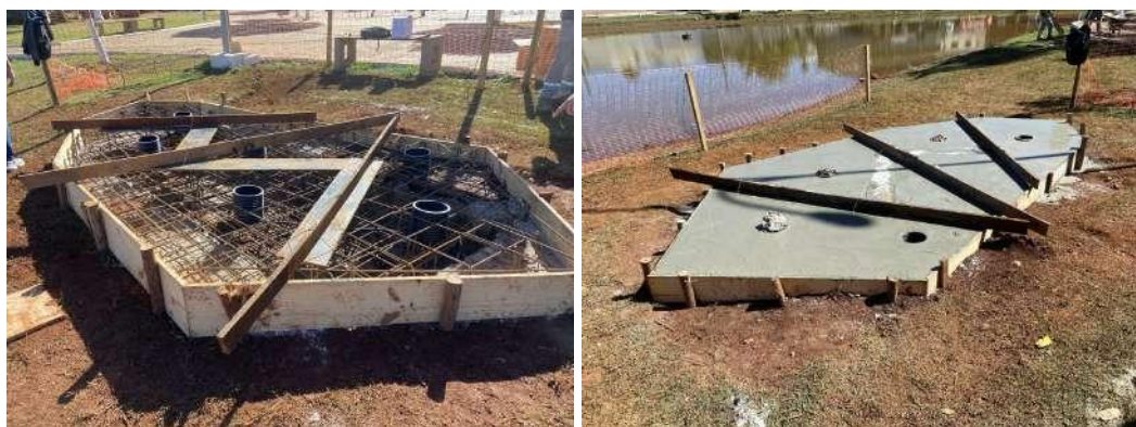
Figura 15 — Construção da base para a escultura em Barão de Cocais
