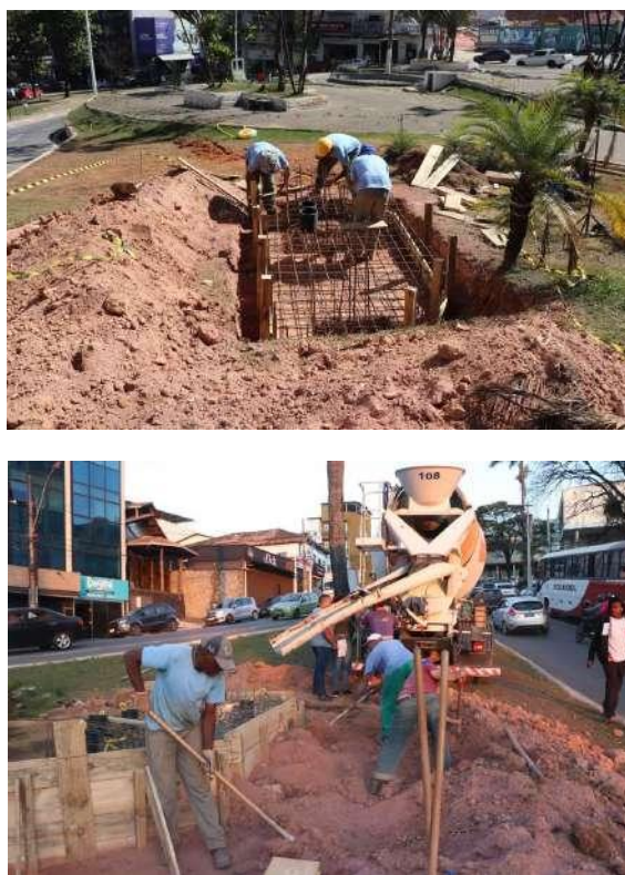
Figura 17 — Construção e concretagem da base para a escultura de Conselheiro Lafaiete
