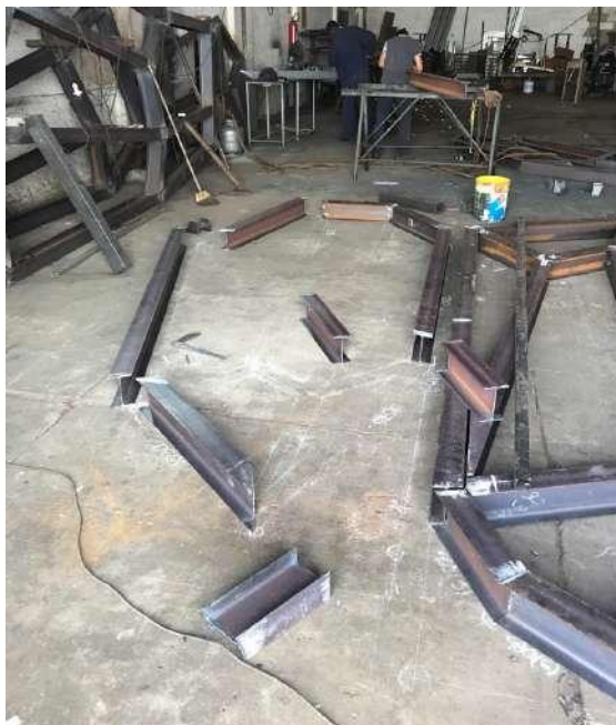
Figura 12 — Cortes das partes dos módulos antes da solda
