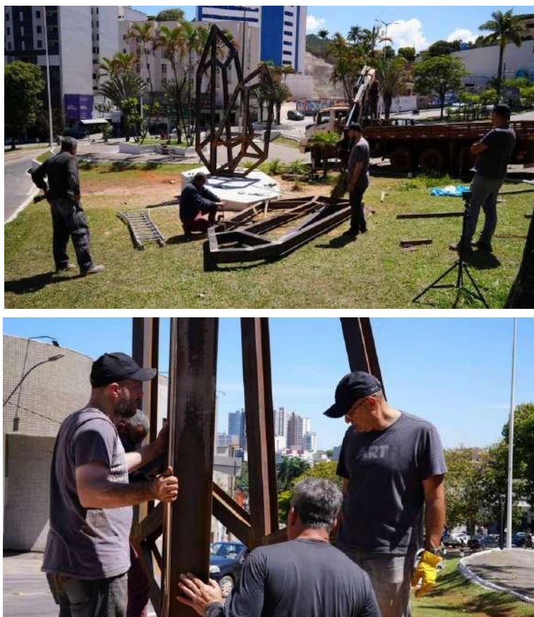
Figura 21 — Instalação da escultura em Conselheiro Lafaiete
