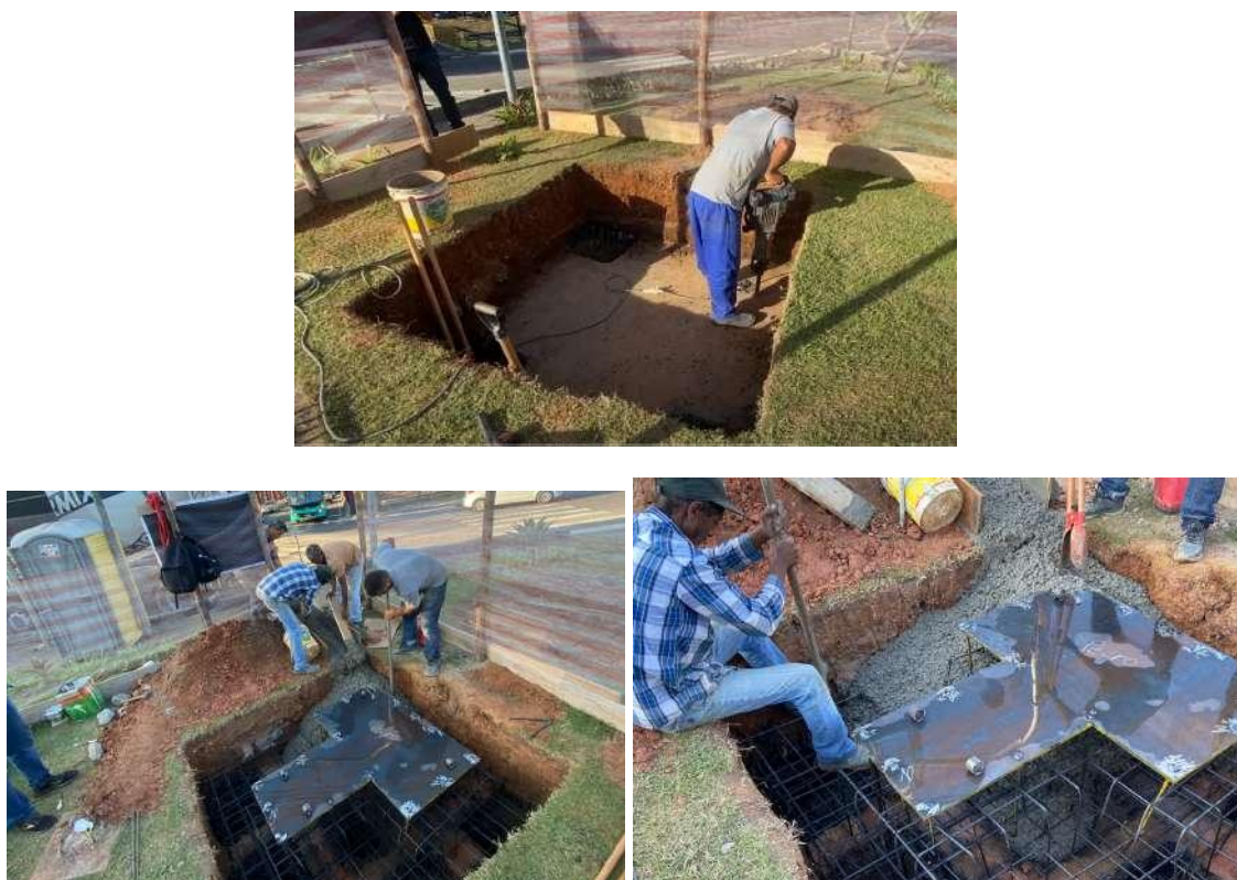
Figura 32 — Etapas de construção e concretagem da base para a escultura
