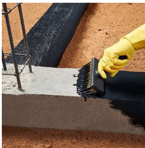
Figura 8 - Impermeabilização de viga baldrame.
