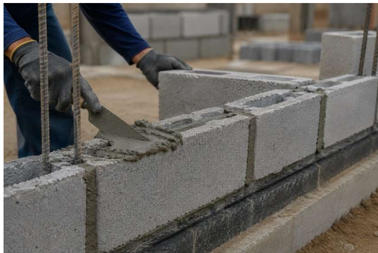
Figura 11 - Assentamento das primeiras fiadas de alvenaria com argamassa aditivada hidrófuga.
