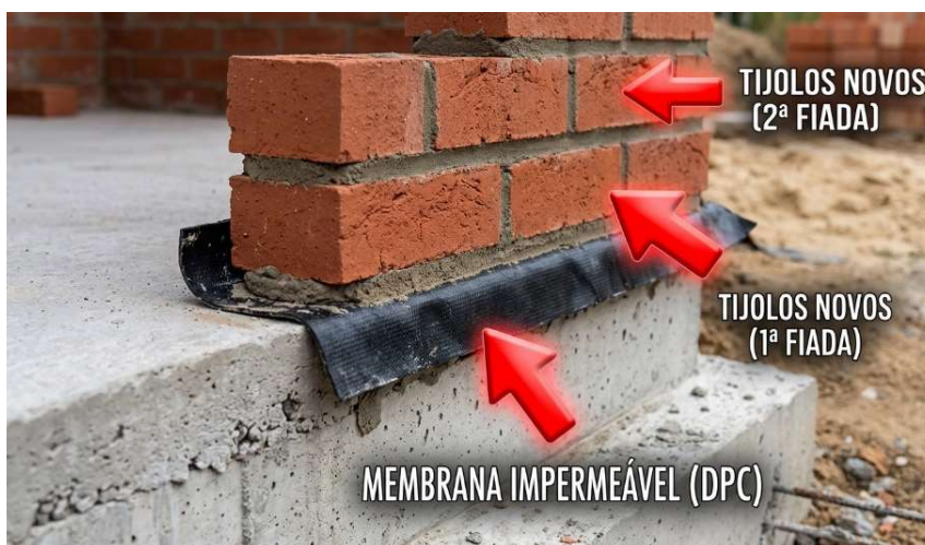
Figura 13 - Representação esquemática da substituição de fiadas.
