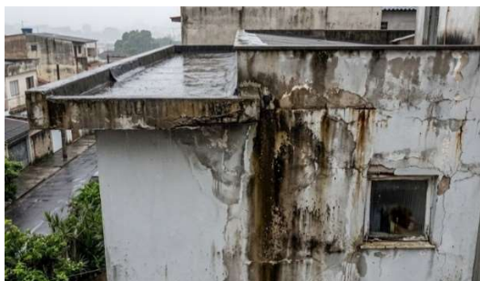
Figura 4 - Manchas escuras em muro externo.
