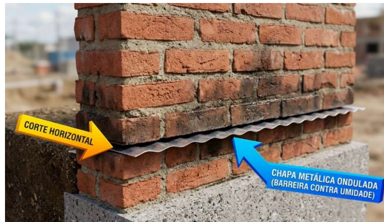
Figura 15 - Representação esquemática do método Schöner-Turn.
