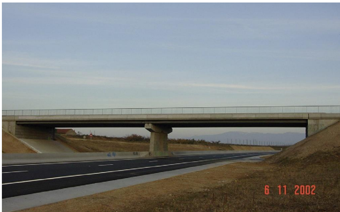
Figura 2 – Viaduto em UHPFRC em Bourg-lès-Valence, França
