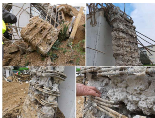
Figura 2 – Casos reais de colapso associados à ruptura por punção
