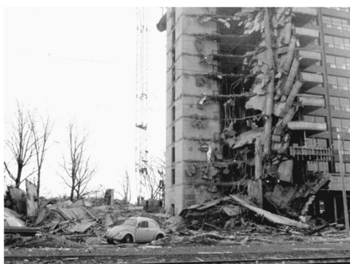
Figura 2 – Casos reais de colapso associados à ruptura por punção
