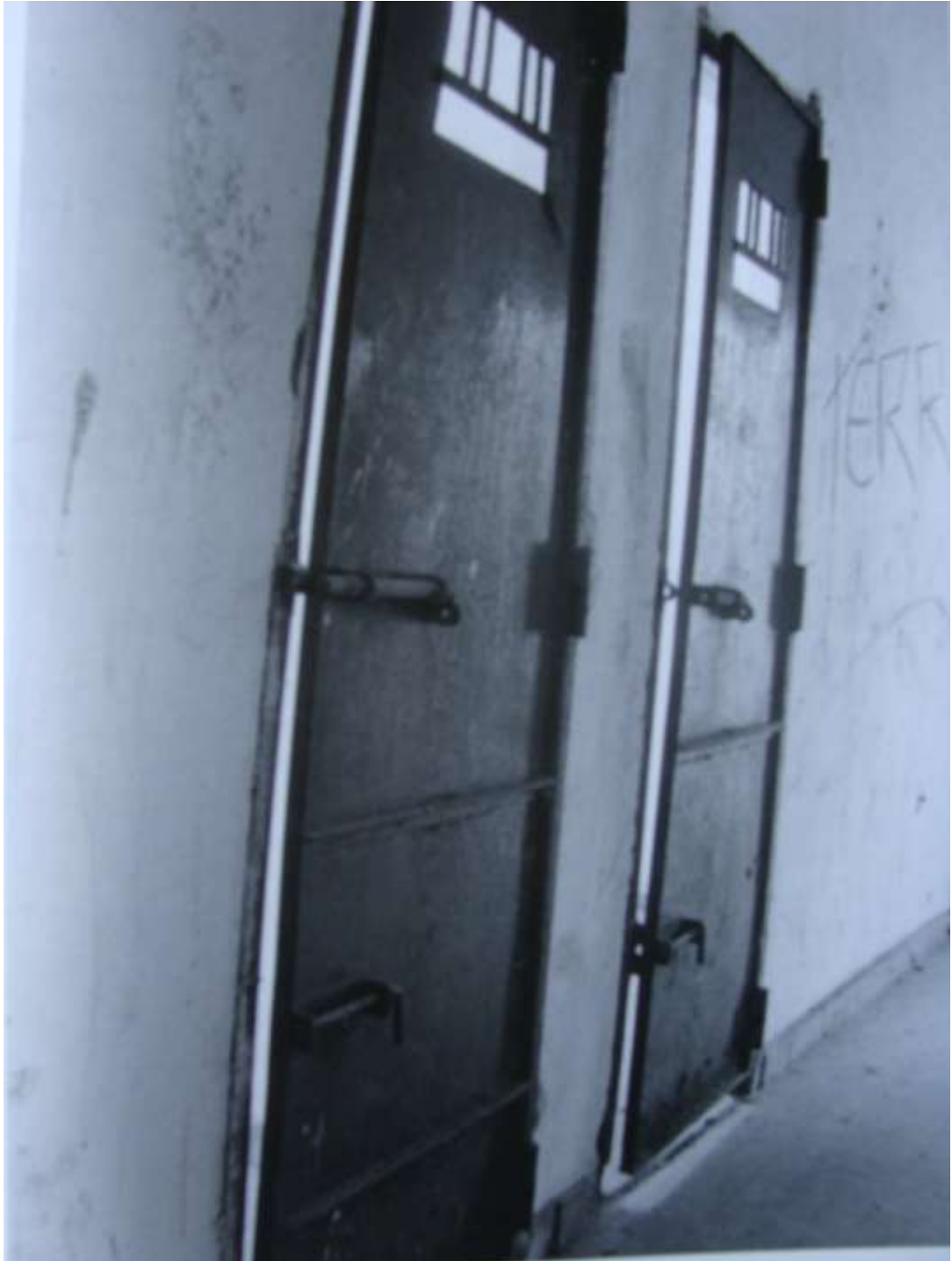
FIGURA 5 - Portas das celas-fortes da Colônia
