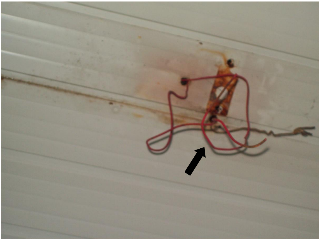
FIGURA 20 - Fiação Exposta
