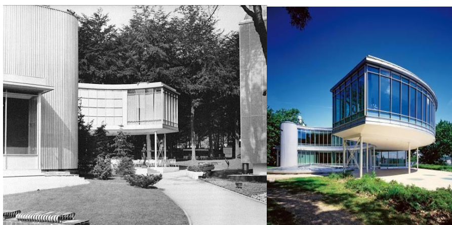
Figura 10: Restaurante do pavilhão da República Tcheca na EXPO 58 foi reusado em Praga. Fonte: Hechler, 2012
