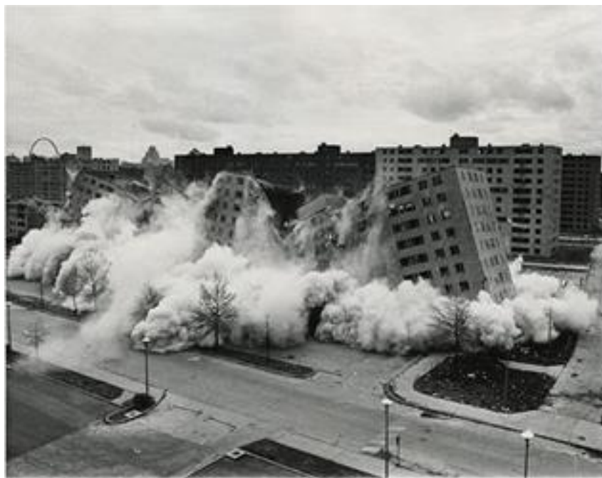
Figura 4: Demolição do conjunto habitacional Pruitt-Igoe, em St. Louis
