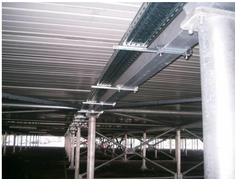
Figura 8: Estrutura de metal no Estacionamento Marignane, em Marseilles, França. Fonte Hechler, 2012
