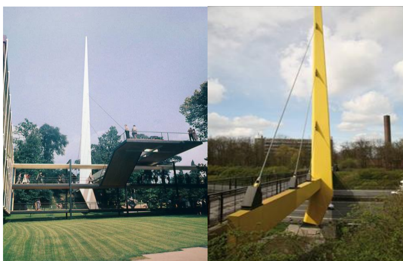
Figura 9: Ponte para o pavilhão na Alemanha (esquerda) e o reuso em Duisburg, na Dinamarca. Fonte Hechler, 2012
