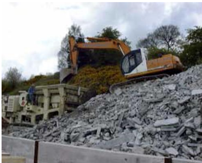
Figura 3: Trituração e seleção de componentes de concreto em agregados reciclados Fonte: HOBBS & HURLEY, 2001.
