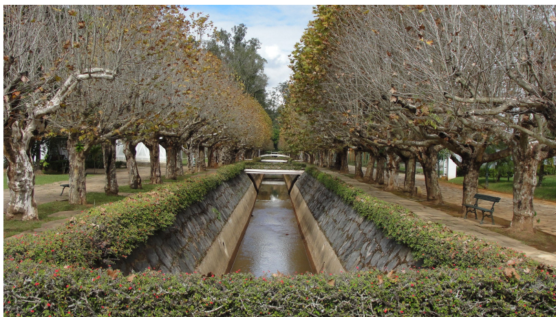
Imagem 61 – O Bengo atualmente dentro do Parque. Fonte: fotografia do autor.
