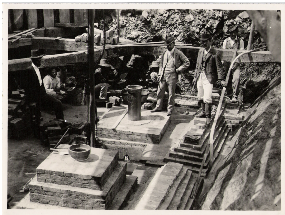
Imagem 12 - Construção da estrutura em alvenaria das fontes do pavilhão principal, 1905/1906. Fonte: Acervo Fotográfico, Museu das Águas – Lambari/MG.
