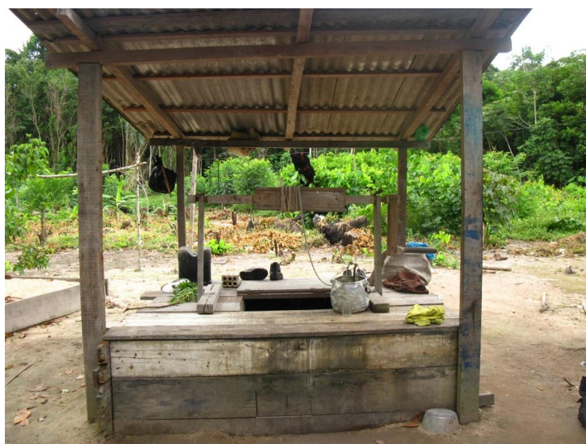
Figura 12: Poço para fornecimento de água.
