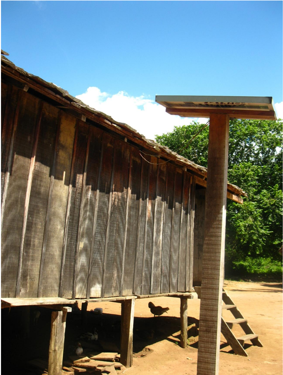
Figura 11: Moradia com energia elétrica proveniente de placa solar.
