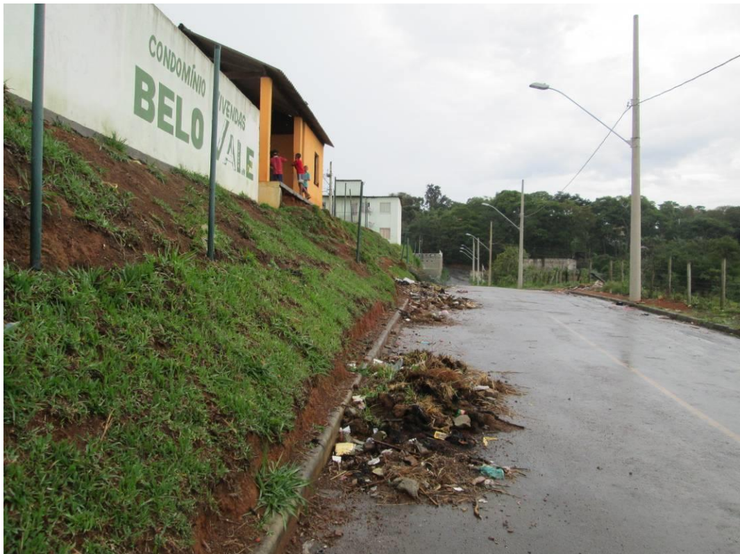
Figura 2: Fachada do condomínio
