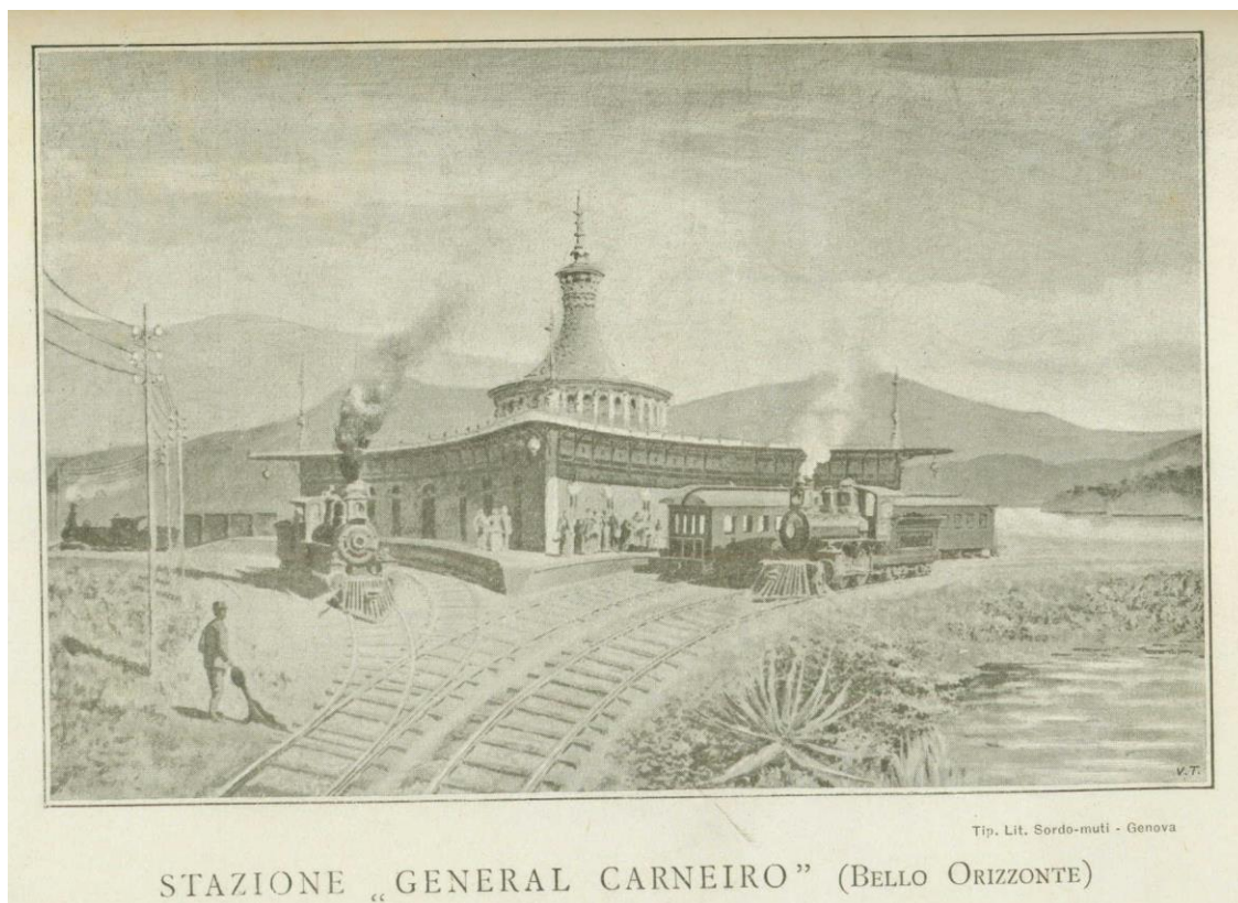
Figura 20 – Estação de General Carneiro (Belo Horizonte)
