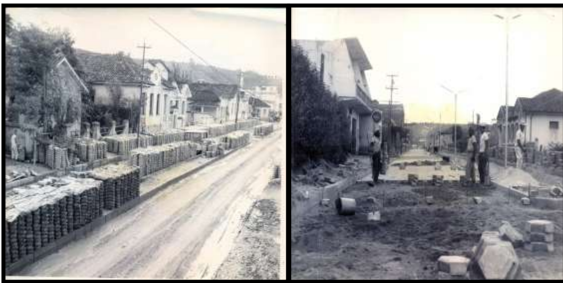
Figura 7a. Avenida Professor Ph. Rolfs de terra (à esquerda). Figura 7b. Preparação da Avenida Professor Ph. Rolfs para receber os bloquetes (à direita).
