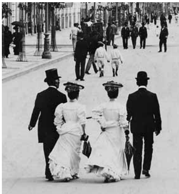
Detalhe do footing na Avenida Central. Foto de Augusto Malta. Fonte: KOK, Glória. 2005, p. 82
