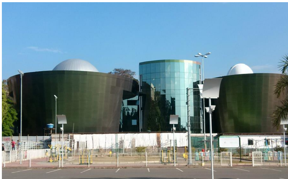
Imagem 17 - Nova sede do Centro de Ciências da UFJF, no Campus Fonte: Acervo pessoal da pesquisadora, 2015.
