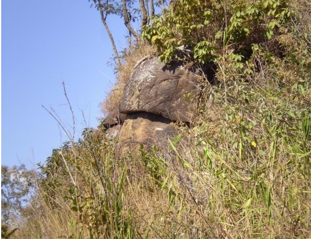
Figura 29 – Fotografia de bloco rochoso muito instável situado no topo da trilha do meio
