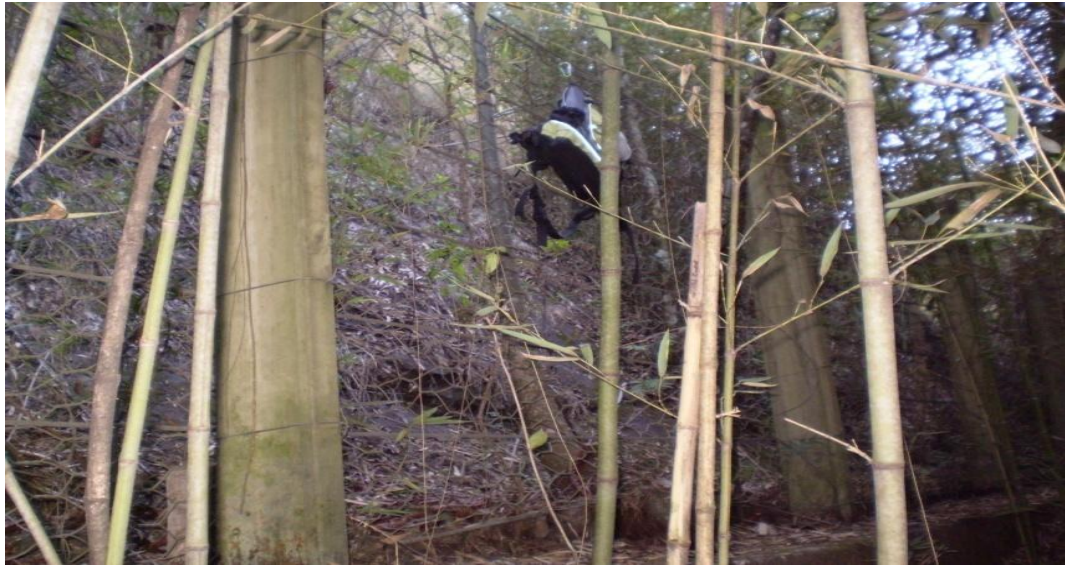
Figura 11 - Fotografia das paliçadas para barramento de blocos rochosos à montante da Rua Renato Cruz Frederico
