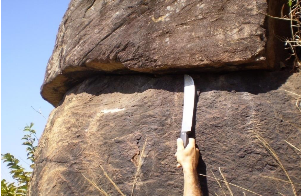
Fotografia 30 – Fratura e deslocamento de bloco de rocha
