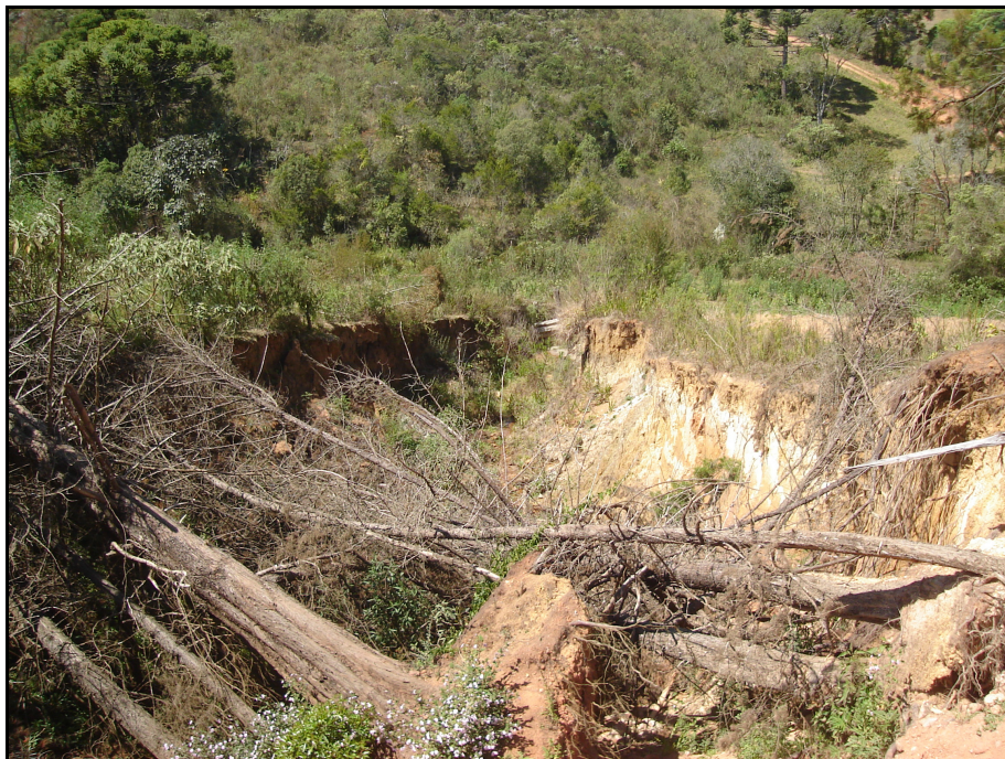
Figura 25: Processo erosivo por retirada de cobertura vegetal.
