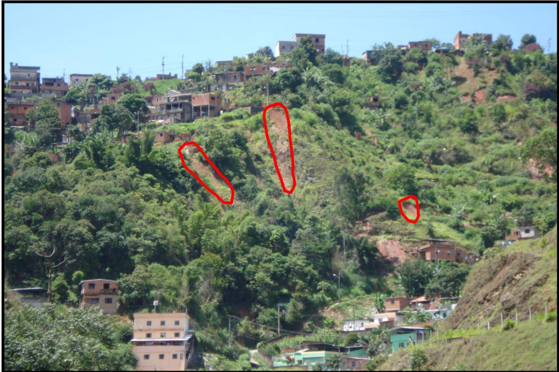
Figura 23: Área classificada como Instável pelo modelo SHALSTAB. Percebe-se a presença de 3 movimentos de massa induzidos pela ação antrópica e potencializados pela declividade local
