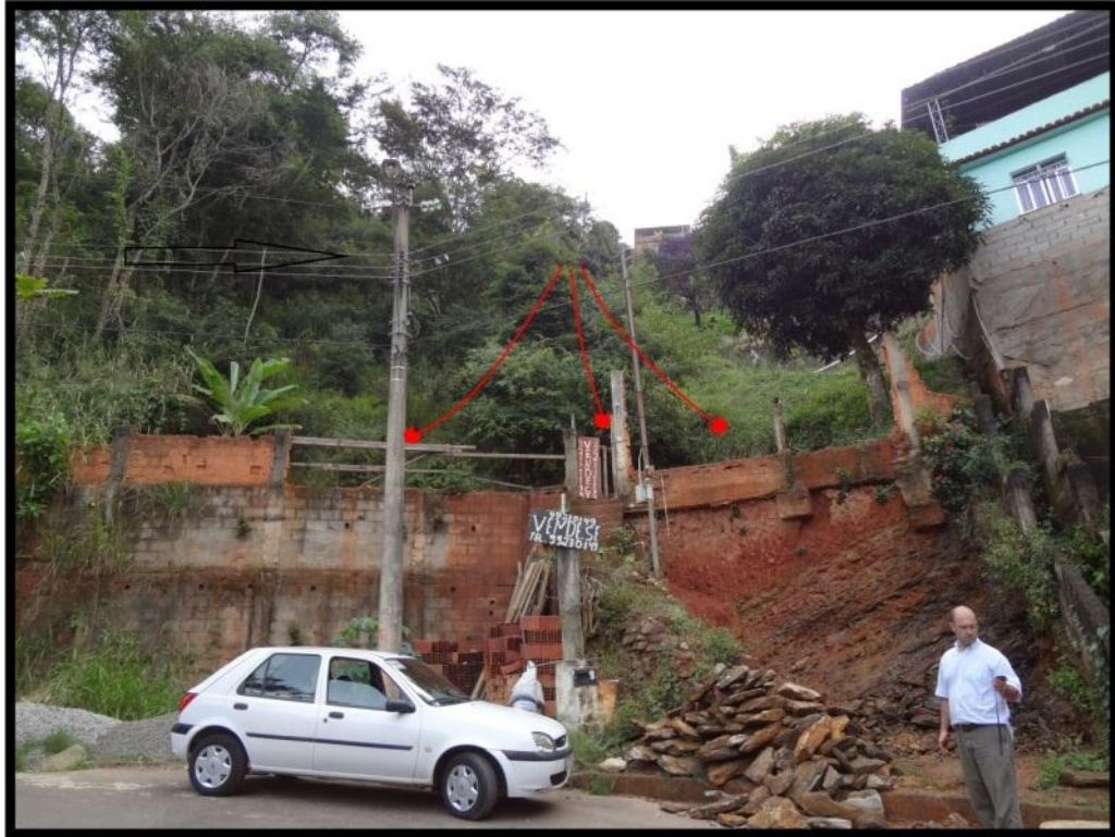
Figura 20: Exemplo de uma área com movimento de massa induzido em uma porção do relevo com grande concentração de fluxo d'água conforme se observa no corte do terreno próximo à rua. Devido à combinação de alta declividade e a alta concentração de fluxo d'água houve no local o colapso de 3 casas.
