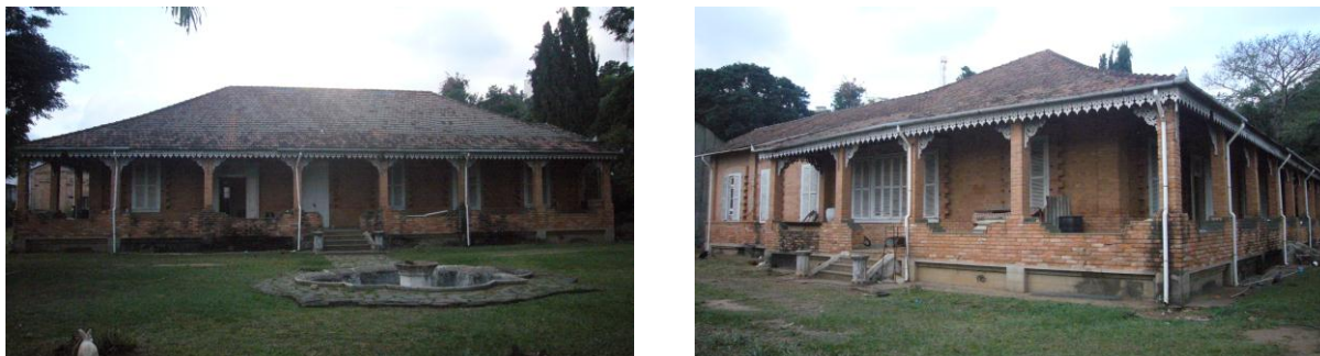
Figuras 70 e 71: “Casa dos Hóspedes” – Cia. Têxtil Ferreira Guimarães (Fotos Claudia Gaspar Cimino, 2013).
