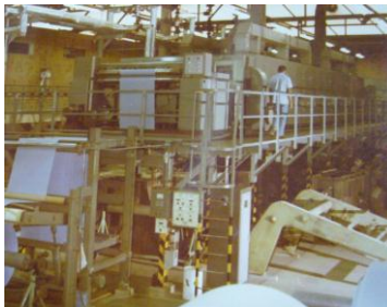
Montagem da Rama (Foto do arquivo interno da Cia. Têxtil Ferreira Guimarães)
