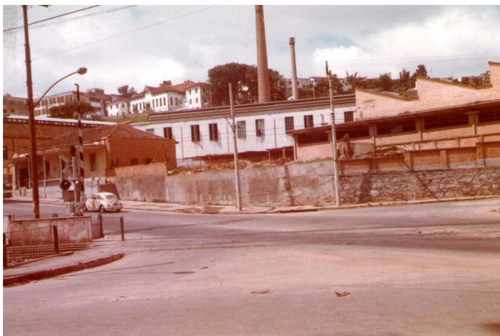
Figura 17: Início da demolição dos galpões da Ferreira Guimarães, março 1998 (Foto cedida por Cristina Sirimarco).
