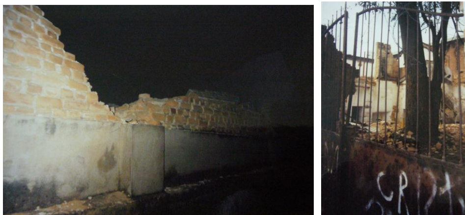
Figuras 64 e 65: Demolição dos galpões da Fiação e Tecelagem (Fotos cedidas por Antônio Carlos Teixeira).
