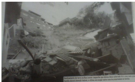
Figura 3: Escorregamento no Bairro Nossa Senhora Aparecida. Fonte: Silva, 2009.
