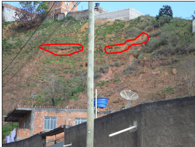
Figura 38: Registro de área com cicatriz induzida, devido a influência das ocupações encontradas no topo do morro.
