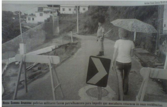
Figura 1: Escorregamento no bairro Nossa Senhora Aparecida. Fonte: Cerezo, 2007.
