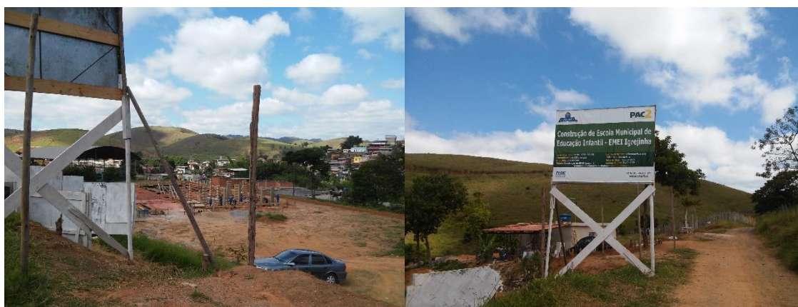
Figura 3 - Construção da Escola Municipal para o atendimento da Educação Infantil
