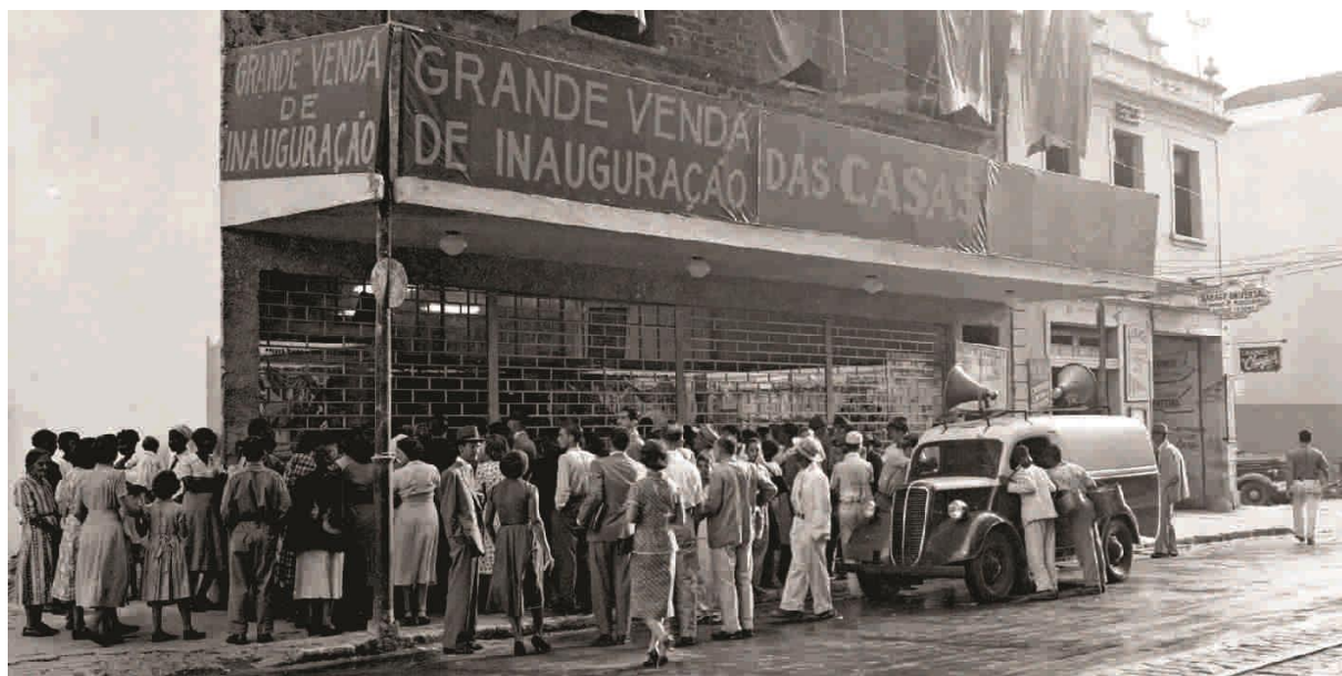
Figura 59: Prédio Anterior ao edifício Marechal shopping, Casas Regente, 1952.
