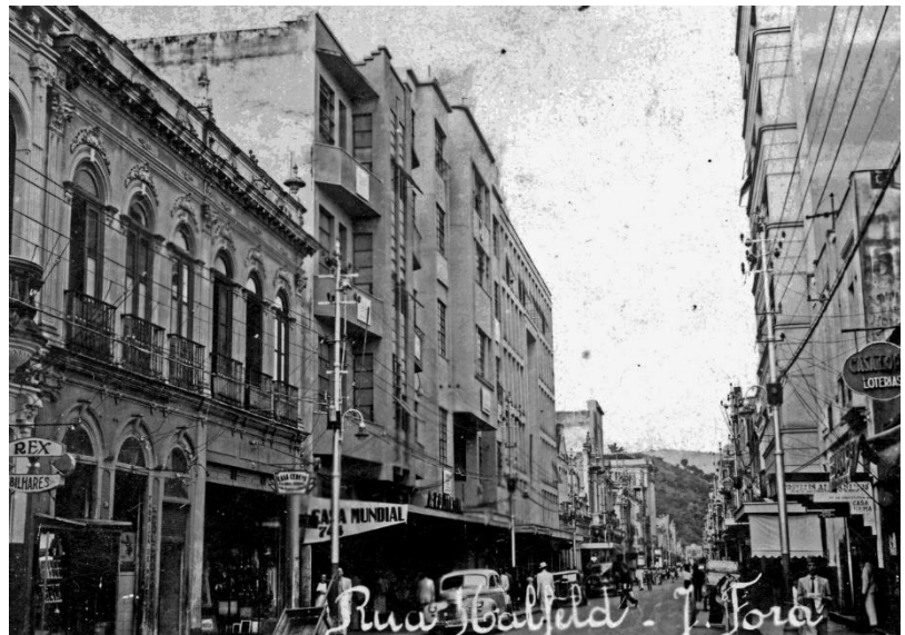
Figura 12: Galeria Pio X, rua Halfeld, (1940-50?)
