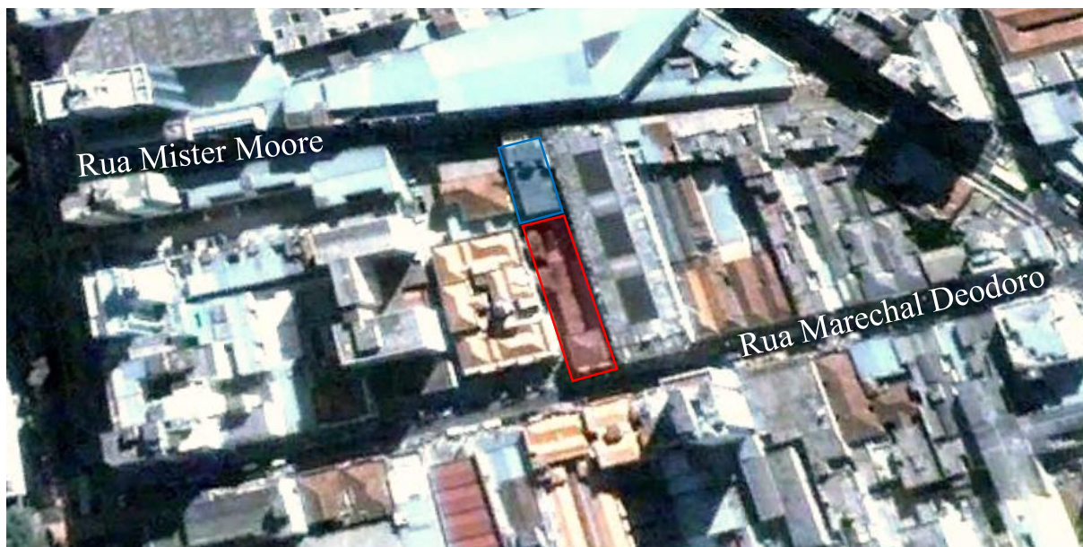
Figura 60: Imagem aérea antes da aquisição do lote, junho de 2006
