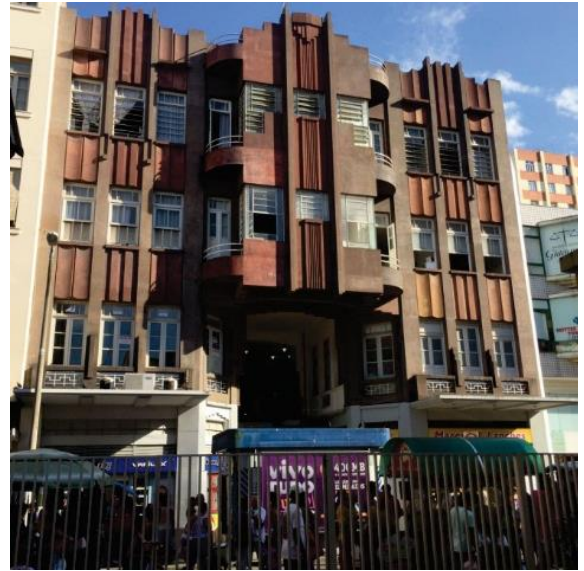
Figura 11: Fachada da galeria Pio X, Rua Marechal Deodoro, 2016
