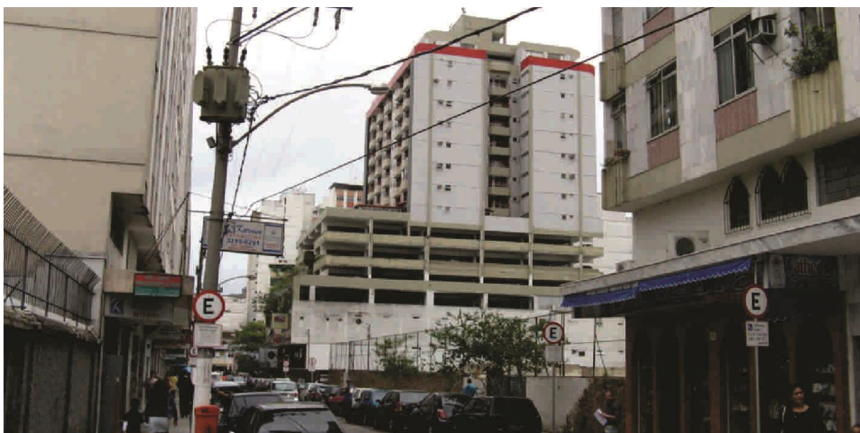
Figura 25: Terreno vazio, antes da construção do edifício Pátio Central.
