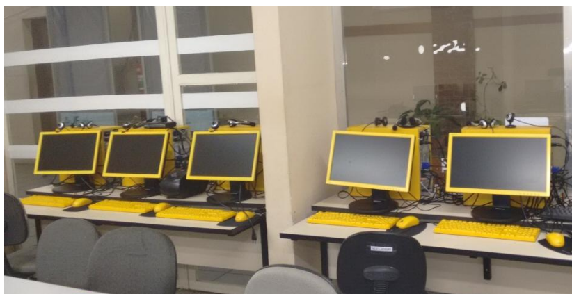
Figura 8: Computadores recebidos pelo NTM ainda não instalados - precariedade da rede elétrica na SE-JF
