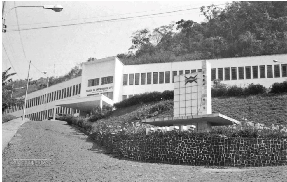
Figura 4 – Escola de Engenharia da Universidade Federal de Juiz de Fora
