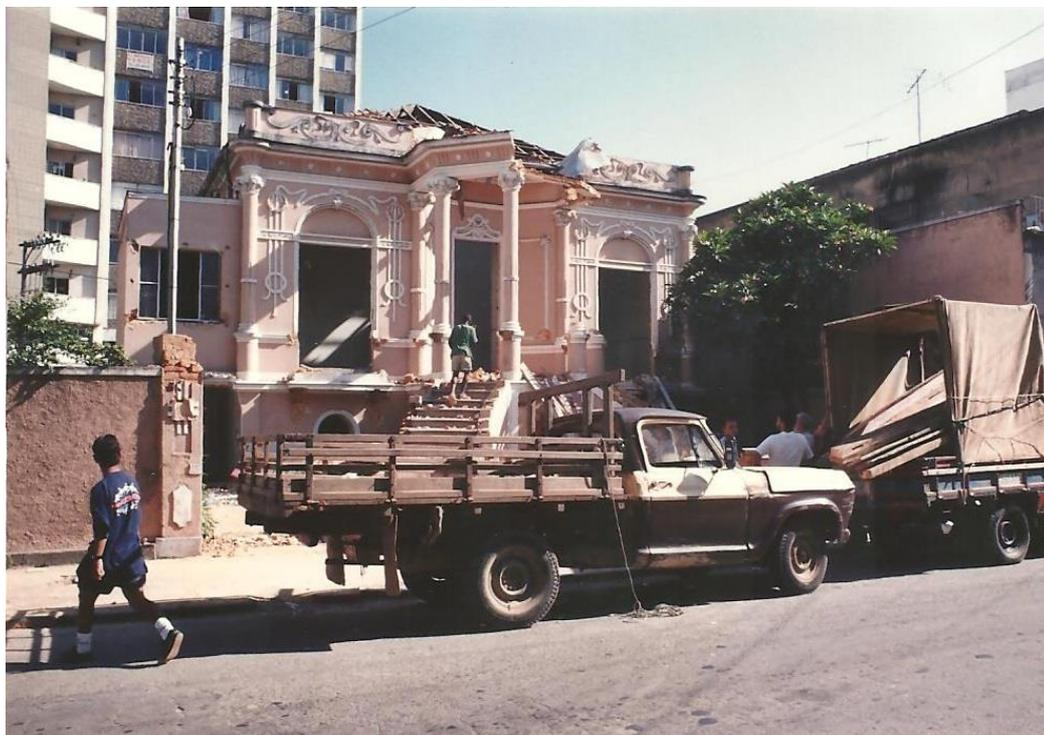
Figura 46 – Nota-se a retirada dos elementos artísticos da edificação. 11.02.1994.
