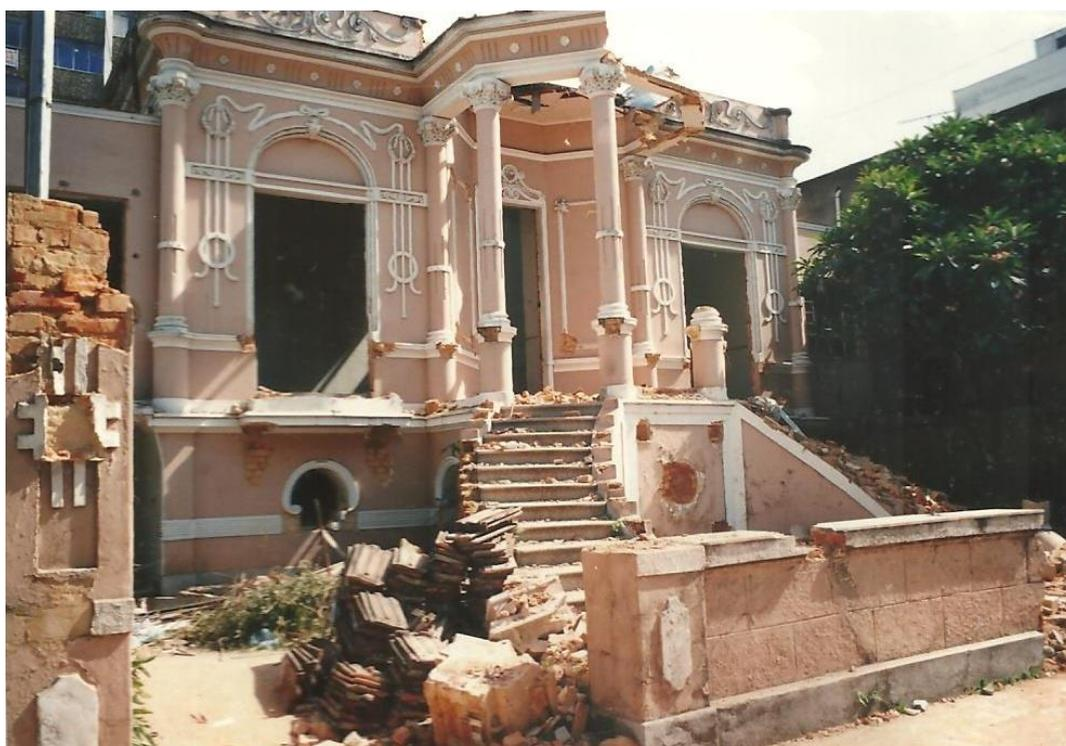
Figura 47 – Vista da varanda octogonal após o início da demolição. Nota-se a retirada das duas colunas de sustentação e parte da cobertura da varanda. 11.02.1994.
