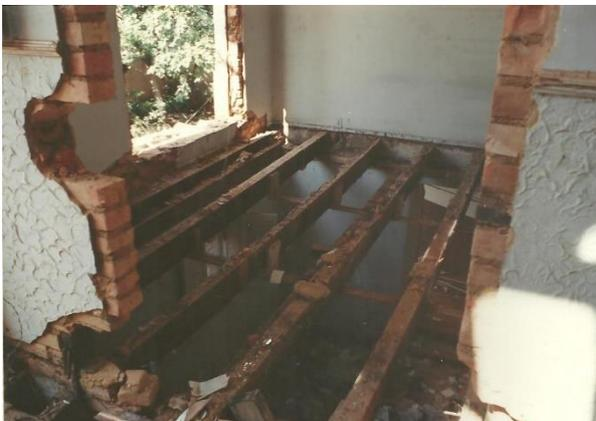
Figura 50 – Vista interna de um dos forros de madeira pintado em tabuado liso sendo retirado com abertura para a estrutura do telhado. 11.02.1994.
