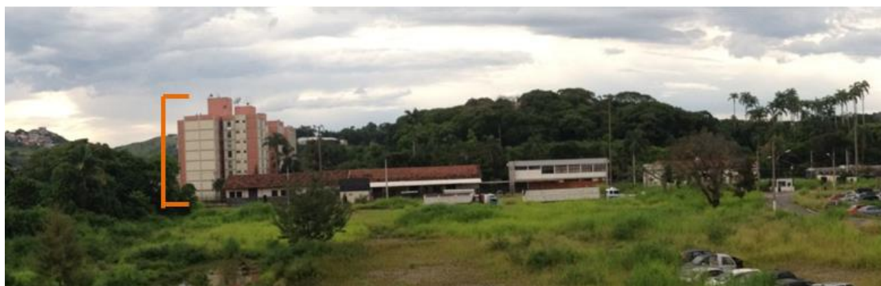
Figura 25- Imagem da edificação consolidada.
