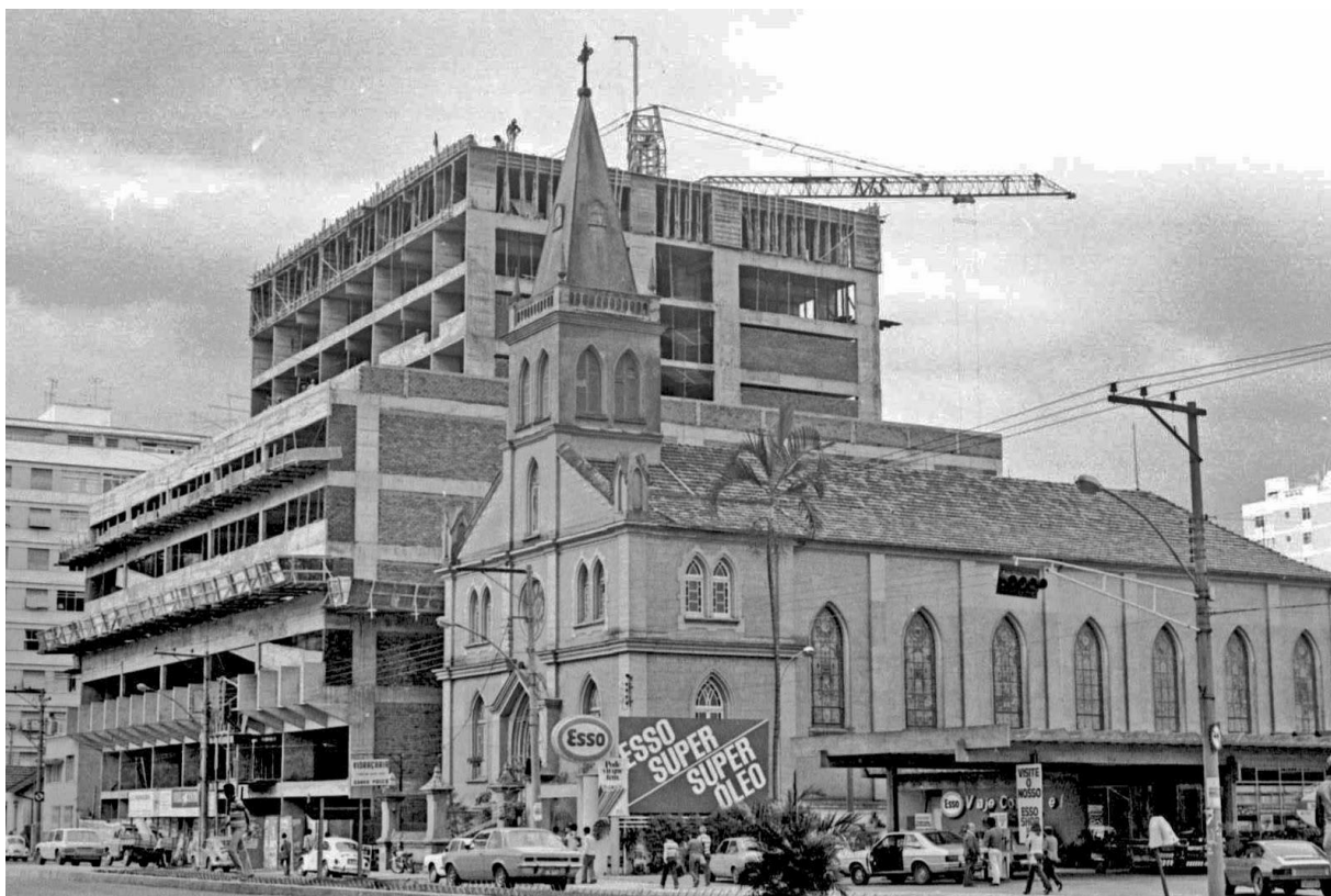
Figura 5 – Foto tirada em 1980, já com o Colégio demolido restando apenas sua capela que posteriormente também foi demolida. (autoria da foto de Jorge Couri)
