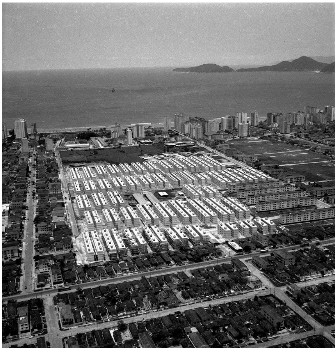
Figura 11. Conjunto Habitacional Humberto de Alencar Castelo Branco, no Bairro Aparecida, Santos. Primeiro conjunto construído pelo BNH, em 1973. Disponível em: https://goo.gl/b5laco . Acesso em maio 2017.
