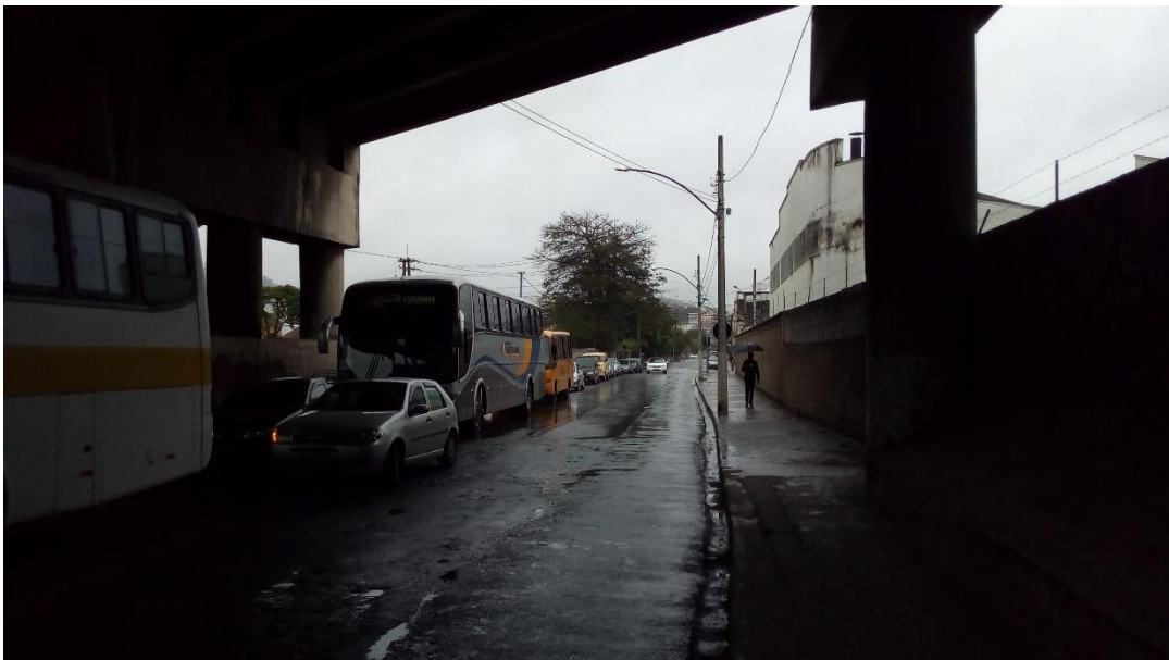
Figura 18 – Baixio do viaduto Augusto Franco
