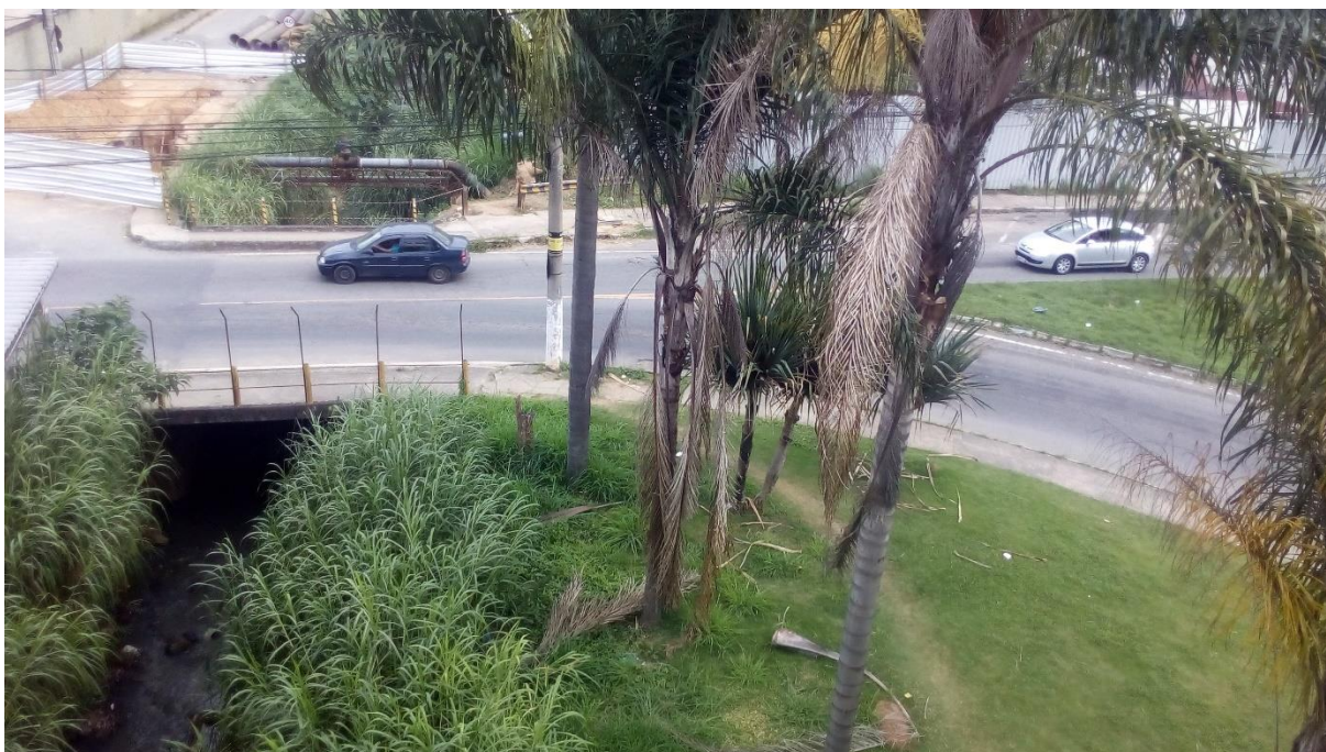
Figura 41 – Córrego passando sob o viaduto próximo ao supermercado Mart Minas
