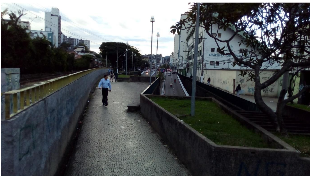
Figura 06 – Vista dos pedestres na parte superior da passagem de nível
