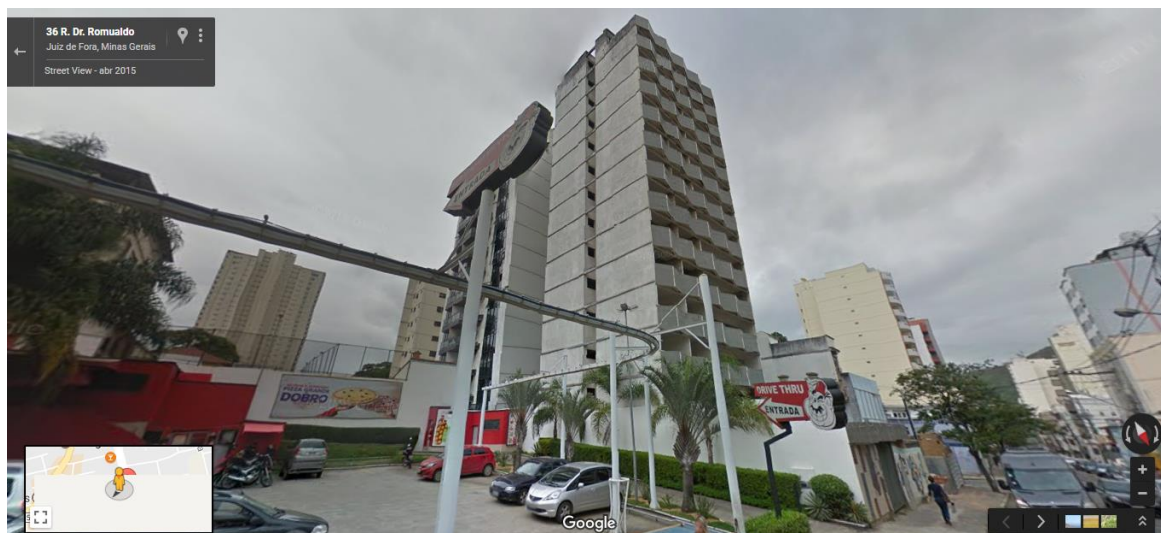
Figura 10 – Edifício abandonado na rua Doutor Romualdo
