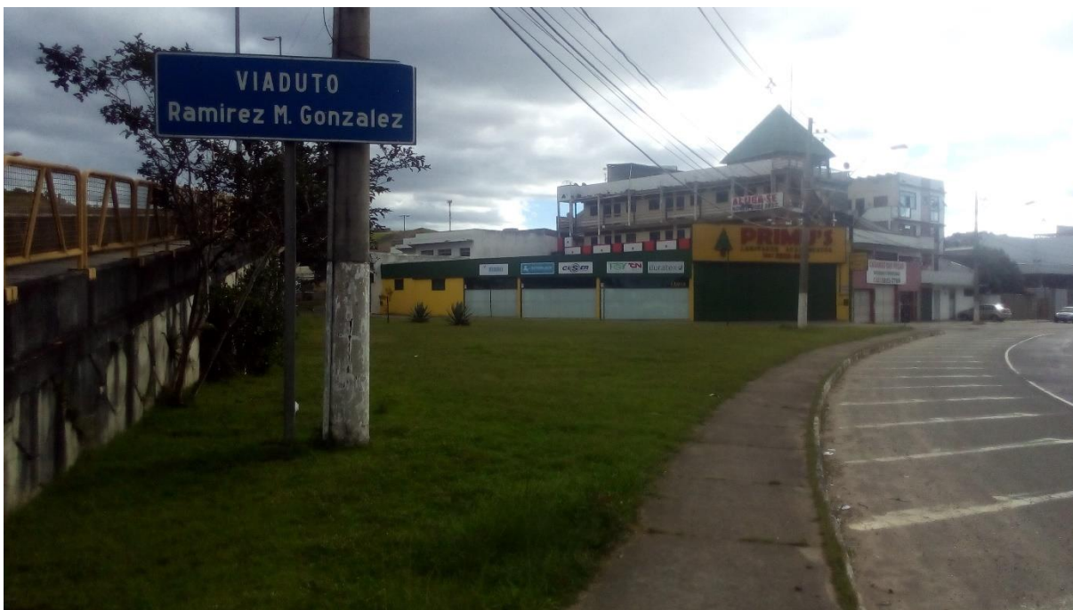
Figura 38 – Vazio faz-se presente embaixo do viaduto próximo ao acesso norte
