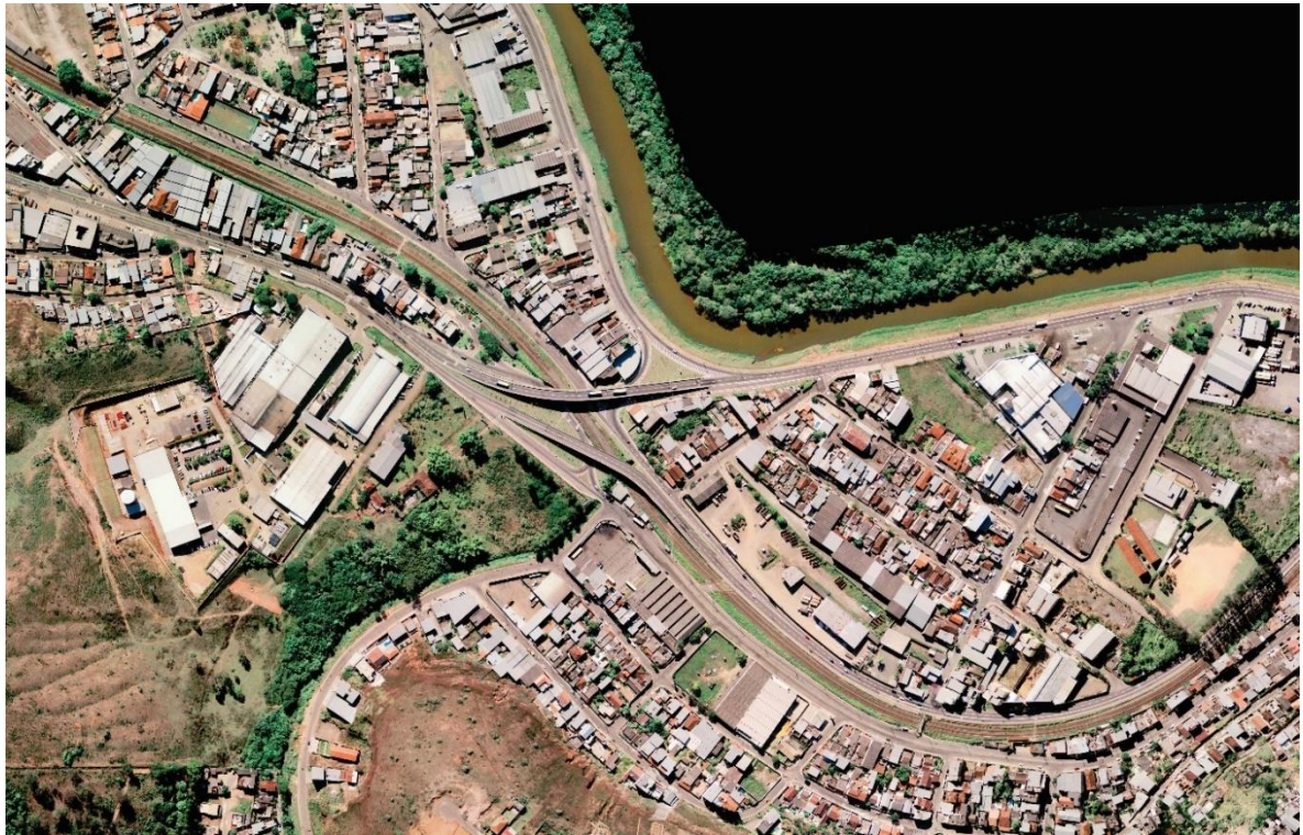
Figura 36 – Área de interesse, viaduto Ramirez Gonzales
