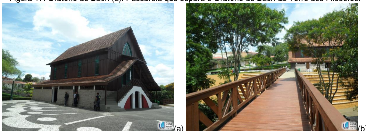
Figura 17: Oratório de Bach (a). Passarela que separa o Oratório de Bach da Torre dos Filósofos.
