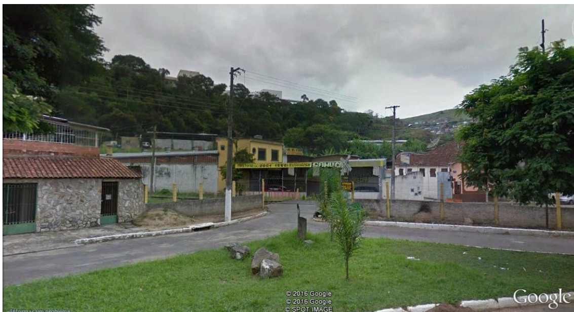
Figura 64 – Passagem em Nível no Bairro Poço Rico, Zona Sudeste. Cruzamento entre a Rua Corina Erse e a ferrovia.
