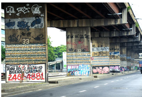
Figura 6 – Trecho sob o Viaduto do Caju, Rio de Janeiro (Brasil).
