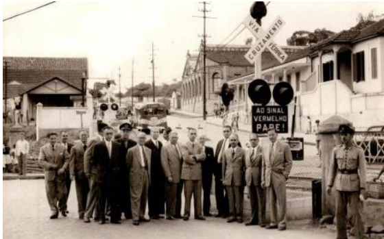
Figura 13 – Personalidades políticas de Juiz de Fora na inauguração dos equipamentos de proteção da passagem em nível no Bairro Mariano Procópio. Foto de 1953.
