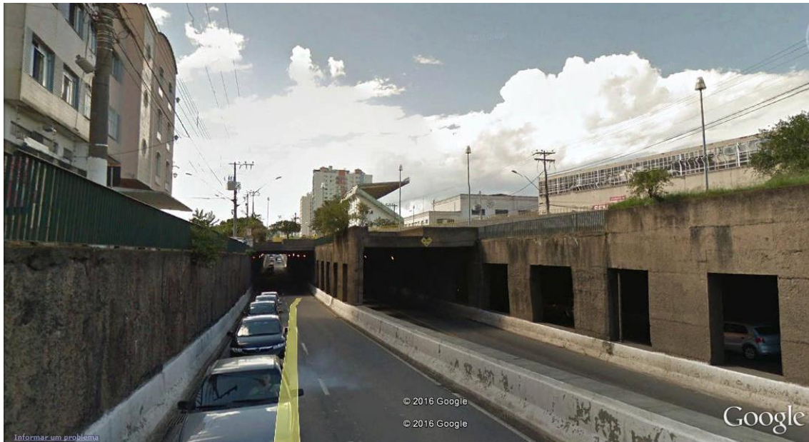
Figura 57 – Passagem subterrânea conectando o Morro da Glória ao Centro da cidade, na Avenida Barão do Rio Branco.
