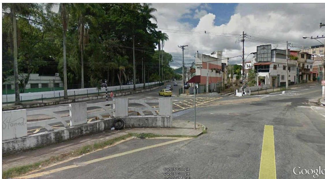
Figura 56 – Passagem em Nível no Bairro Mariano Procópio, Zona Norte. Cruzamento da Avenida dos Andradas e da Rua Benjamin Guimarães com a Rua Mariano Procópio.
