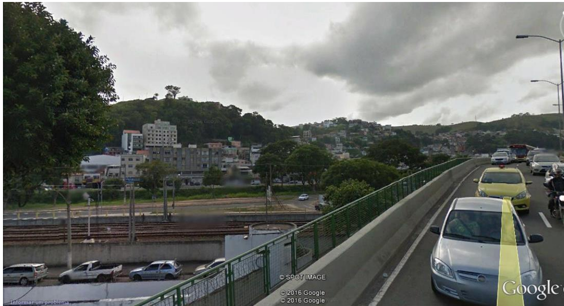
Figura 61 – Viaduto da Avenida Presidente Itamar Franco sobre a ferrovia e a Avenida Brasil no Bairro Centro, Zona Centro.
