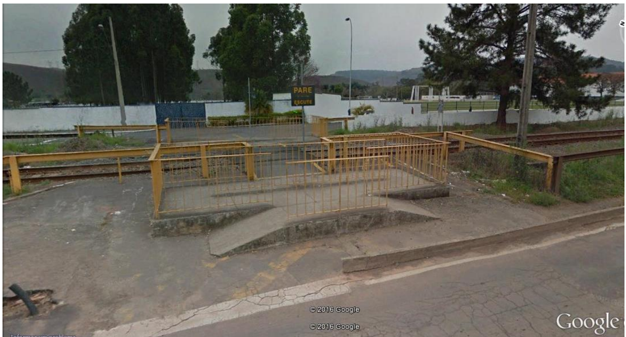
Figura 44 – Passagem para Pedestre em Nível no Bairro Remonta, Zona Norte. Conecta os dois lados da Avenida Presidente Juscelino Kubitscheck.
