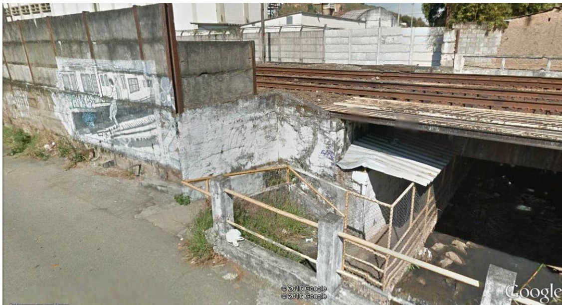
Figura 51 – Passagem para Pedestre no Bairro Industrial, Zona Norte. Conecta a Avenida Presidente Juscelino Kubitschek à Rua Euchério Rodrigues.
