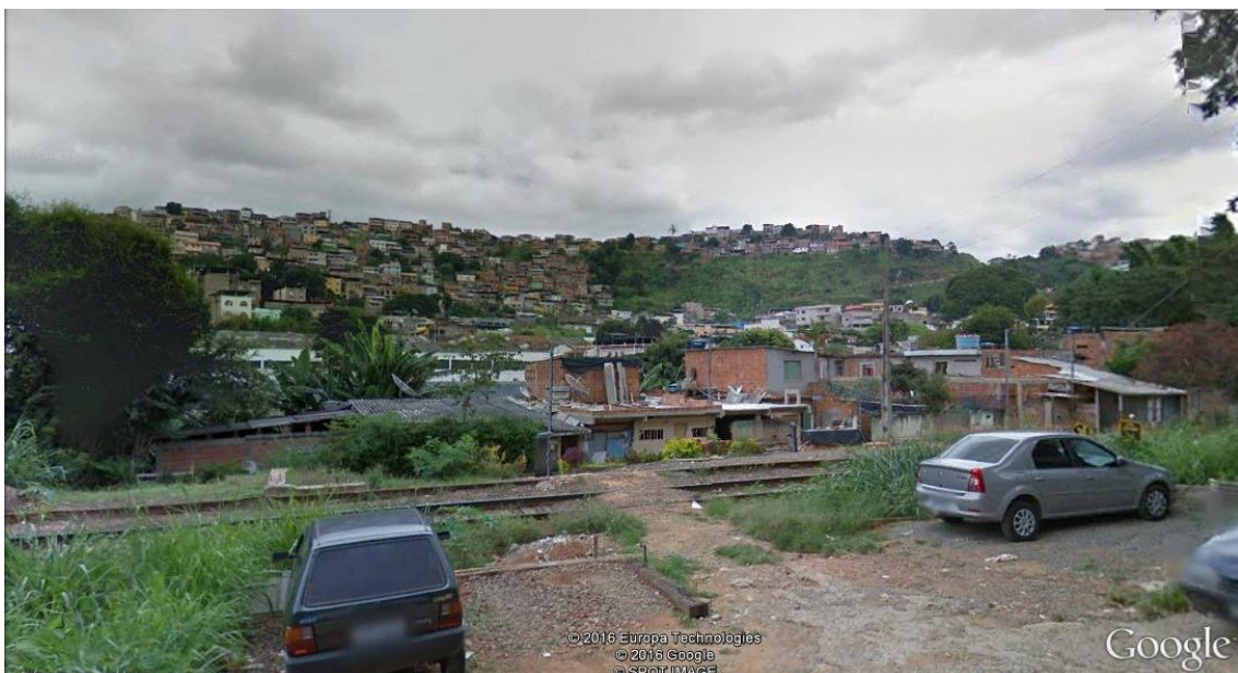
Figura 68 – Passagem para Pedestres em Nível no Bairro Nossa Senhora de Lourdes, Zona Sudeste. Conecta a Rua Horácio de Melo Brandão à margem do Rio Paraíba.
