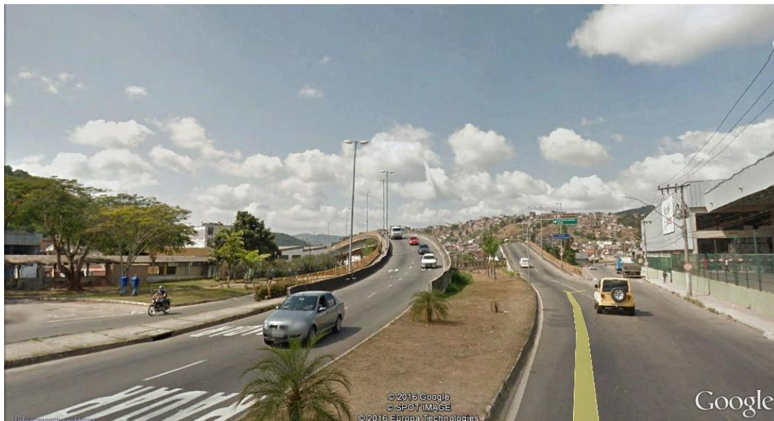
Figura 53 – Viaduto para a transposição da ferrovia no Bairro Cerâmica, Zona Norte. Conecta a Avenida Presidente Juscelino Kubitschek à Rua Coronel Vidal.
