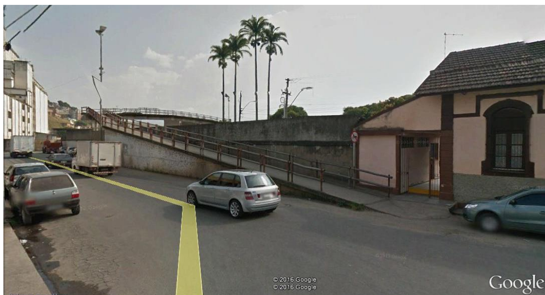
Figura 52 – Passagem para Pedestre no Bairro Industrial, Zona Norte. Conecta a Rua Berta Halfeld Paleta à à Rua Euchério Rodrigues.
