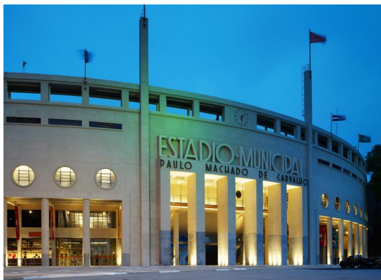
Figura 21. Acesso frontal do Pacaembu, onde se encontra o Museu do Futebol. Disponível em: < http://www.archdaily.com.br/br/757567/museu-do-futebol-mauro-munhoz-arquitetura >. Acesso em 13 de jun. 2017.
