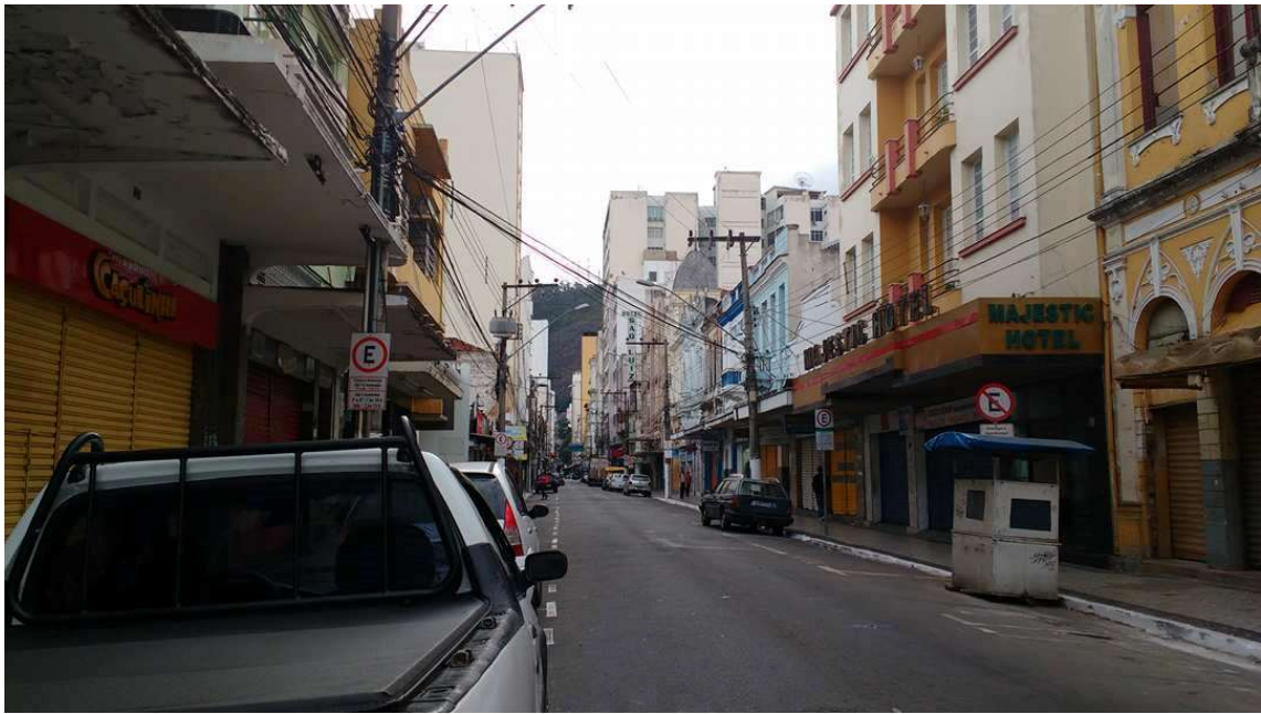
Figura 41: Postes e fiação comprometem a leitura de edifícios tombados na Rua Halfeld entre a Praça da Estação e Av. Getúlio Vargas.
