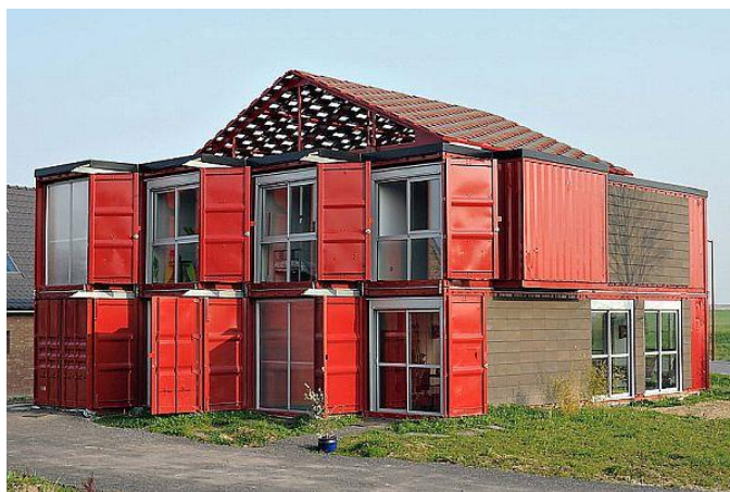
Figura 25: O uso repetido dos contêineres compõe a fachada dessa residência.
