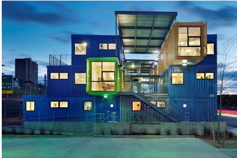
Figura 30: Projeto comercial de 12 escritórios e estúdios feitos a partir de 37 contêineres abandonados sendo a maioria deles pintados de azul, mas com destaque para dois módulos (verde e amarelo) que possuem aberturas maiores.
