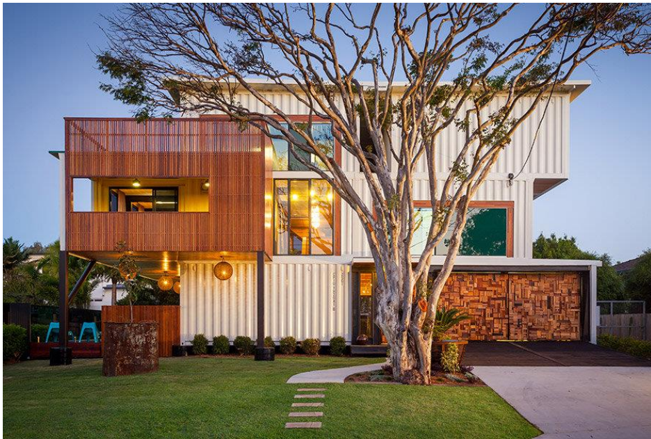
Figura 20: Casa de três pavimentos feita a partir do empilhamento de contêineres e uso de materiais como o aço cortén, madeira e vidro. Fonte: May Robson 23
