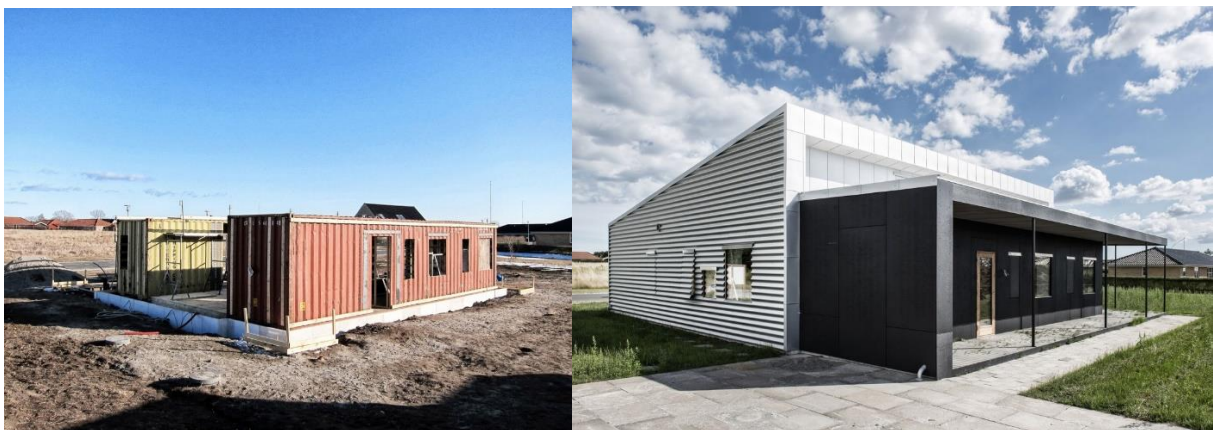
Figura 21: a) Momento de início da construção desta edificação em contêiner na Dinamarca b) Momento final onde diversos tipos de revestimentos foram utilizados para proteger a residência do sol e intempéries além do aspecto estético. Fonte: RAY 24
