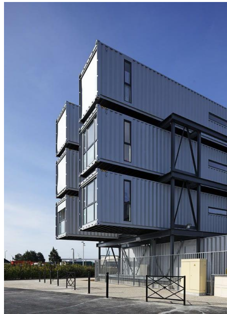
Figura 10: Por esse ângulo é possível verificar como as estruturas atuam no edifício Fonte: Vincent Fillon 13
