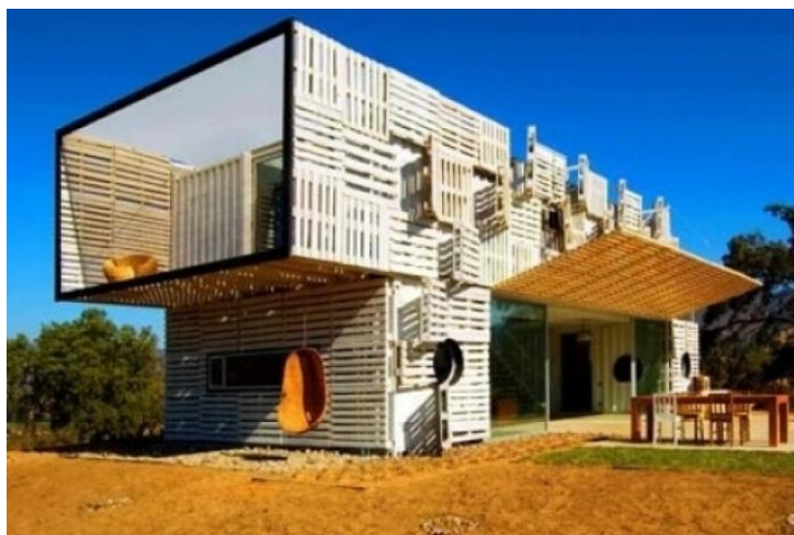
Figura 18: “The Manifesto House” casa projetada pelo escritório James&Mau que emprega paletes reciclados com a função estética e de sombreamento Fonte: CORCUERA 21
