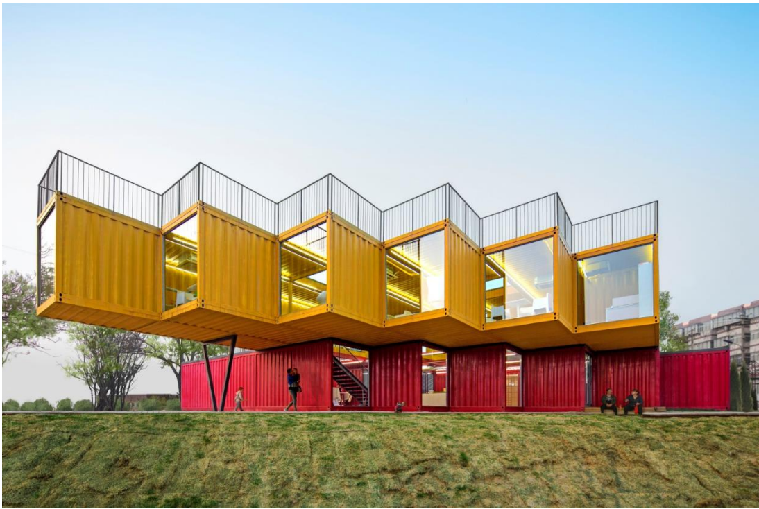
Figura 26: Ritmo obtido pela conjugação de contêineres em um sentido na parte inferior e de forma contrária no pavimento superior Fonte: People's Architecture 29
