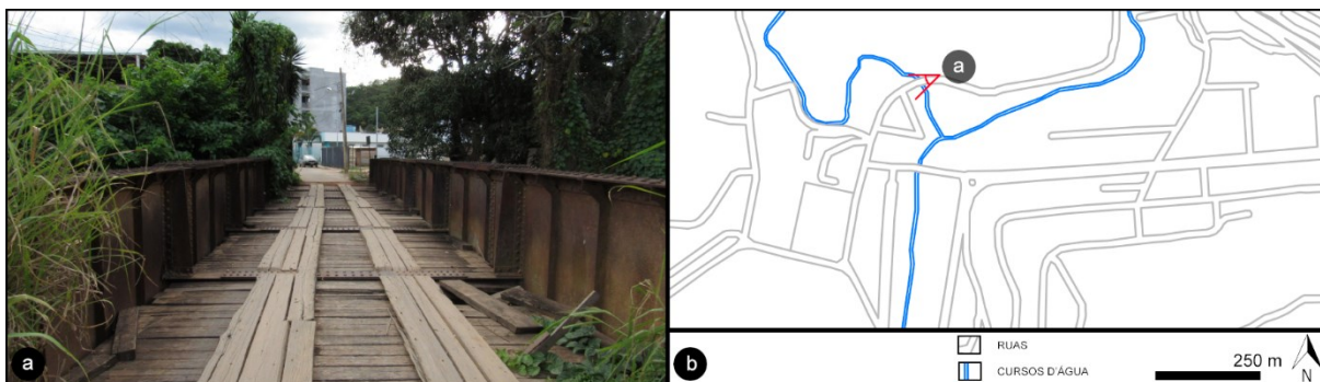
Figura 16a - Pontilhão na Rua Roque Porcaro (2017). Fonte: Acervo da autora.
