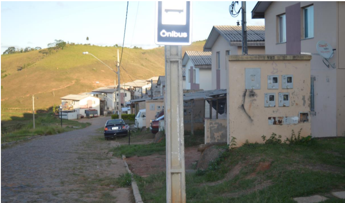
Figura 17 - Ausência de calçamento no passeio.
