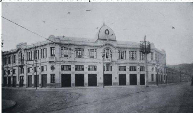
Figura 13: Novo edifício da Companhia e Construtora Pantaleone Arcuri.
