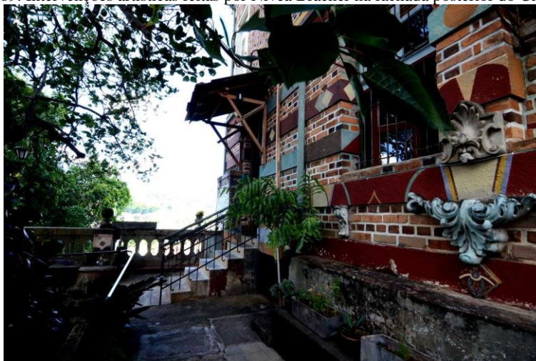
Figura 69: Intervenções artísticas feitas por Nívea Bracher na fachada posterior do Castelinho.
