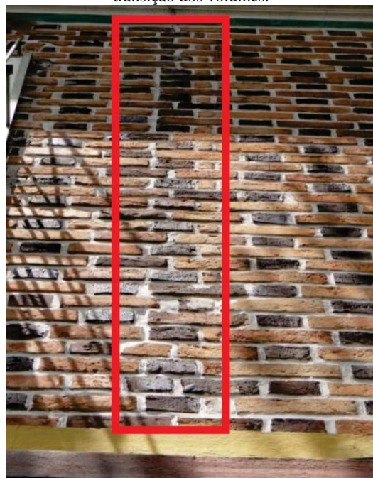
Figura 42: Fileira de tijolos dispostos de forma diferente na fachada posterior. Demarcando a transição dos volumes.
