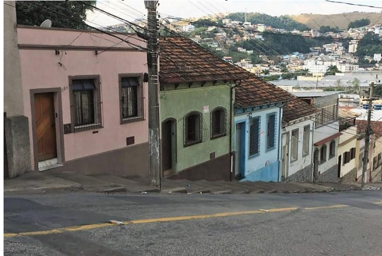
Figura 17: Aspecto atual da Vila Operária da Construtora.
