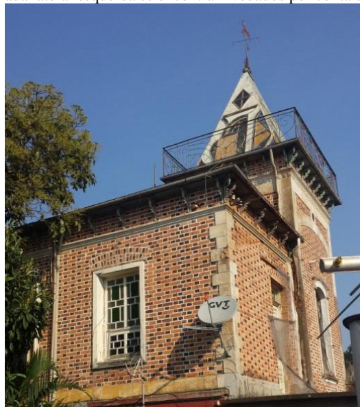
Figura 64: Vãos da fachada lateral esquerda se encontram vedados por conta da ausência de parapeito.
