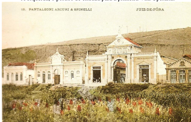
Figura 16: Cartão Postal da Cia. Pantaleone Arcuri & Spinelli. À esquerda, o pórtico de entrada para a primeira Vila Operária.
