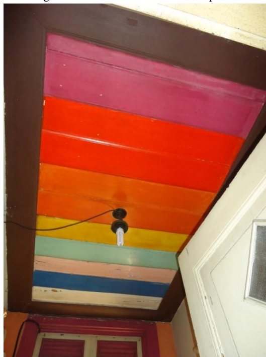
Figura 116: Forro de madeira da despensa.
