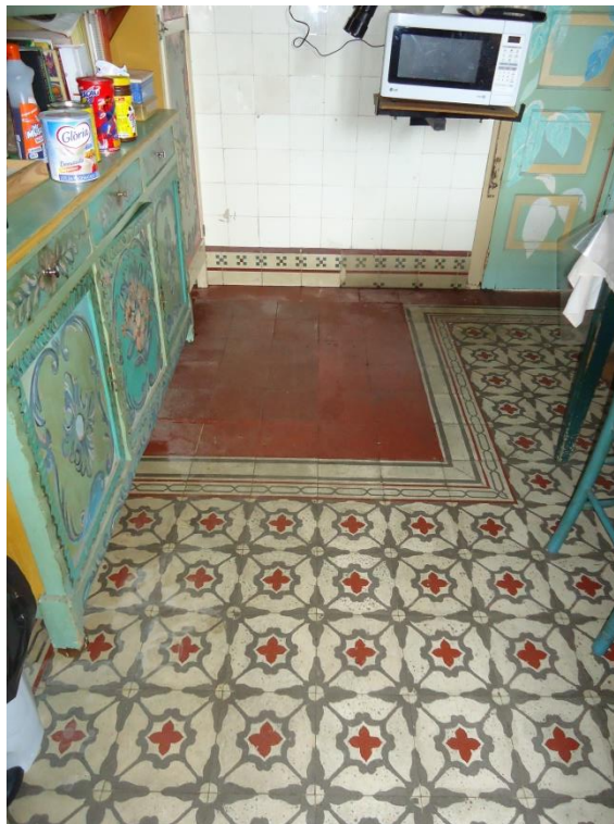
Figura 124: Piso em ladrilho hidráulico da cozinha do Castelinho dos Bracher.
