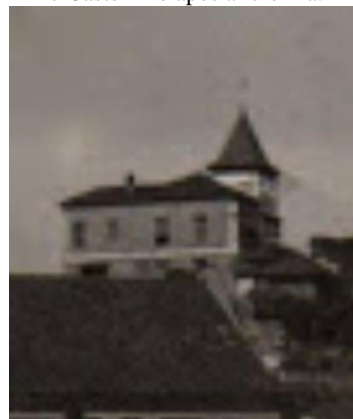
Figura 40: Recorte da Figura 39, destacando o Castelinho após a reforma.
