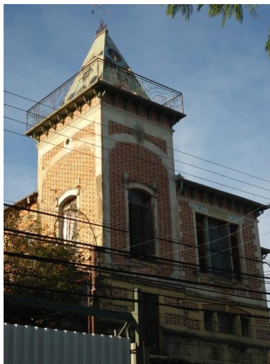
Figura 169: Torre do Castelinho já com mirante e cobertura com aberturas em vidro.
