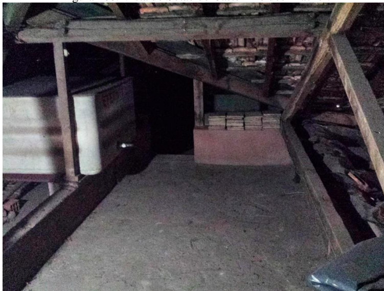
Figura 166: Vista do Sótão do Castelinho dos Bracher.
