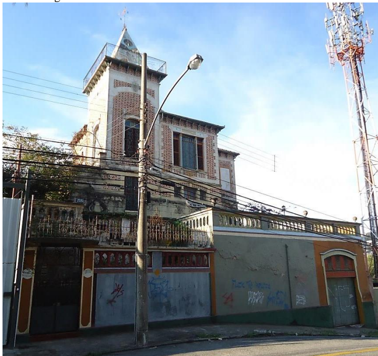
Figura 56: Muro e fachada frontal do Castelinho dos Bracher.
