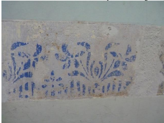
Figura 158: Faixa ornamentada encontrada no quarto 03 – segundo pavimento.
