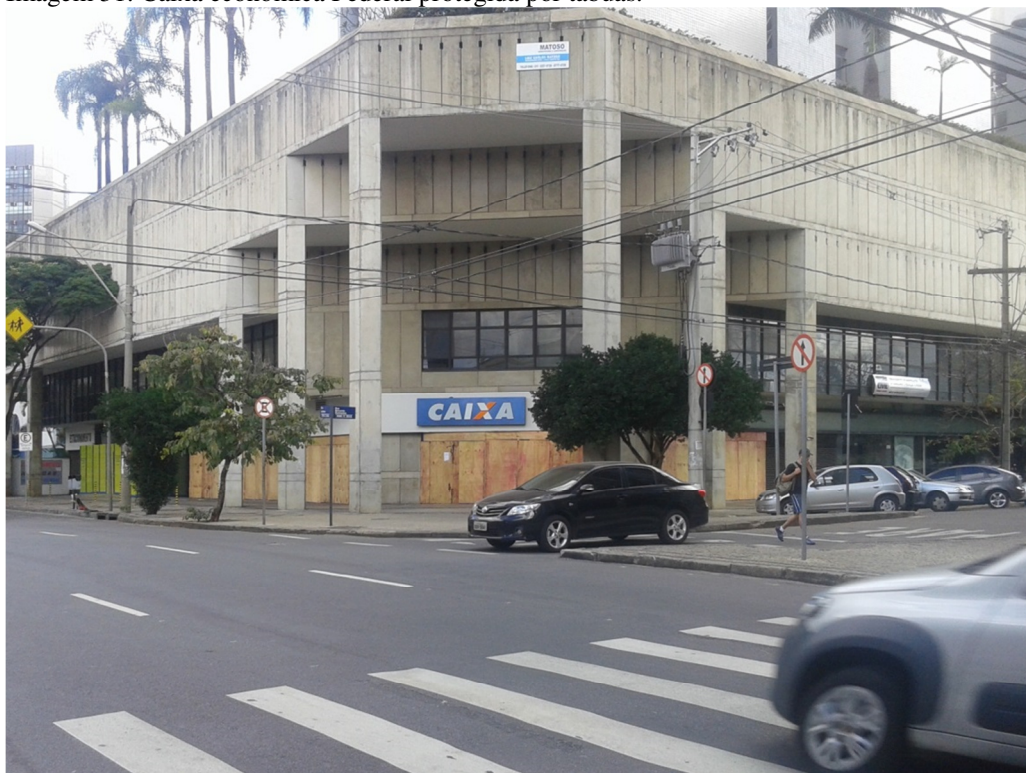
Imagem 31: Caixa econômica Federal protegida por tábuas.
