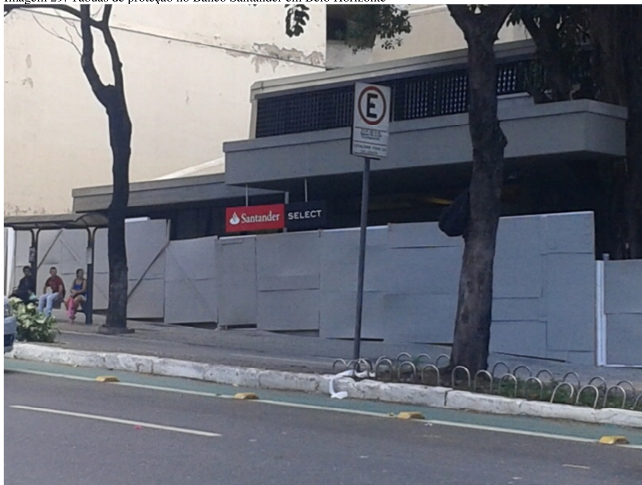
Imagem 29: Tábuas de proteção no Banco Santander em Belo Horizonte
