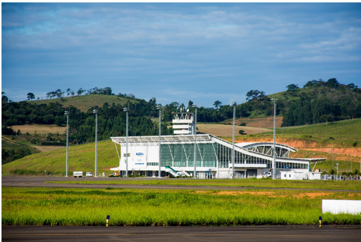
Figura 24 – Vista do saguão de passageiros do SBZM.
