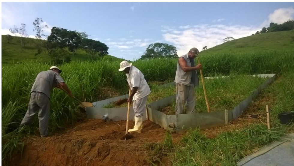
Assentamento da terra para passagem do cano direcionador do escoamento superficial
