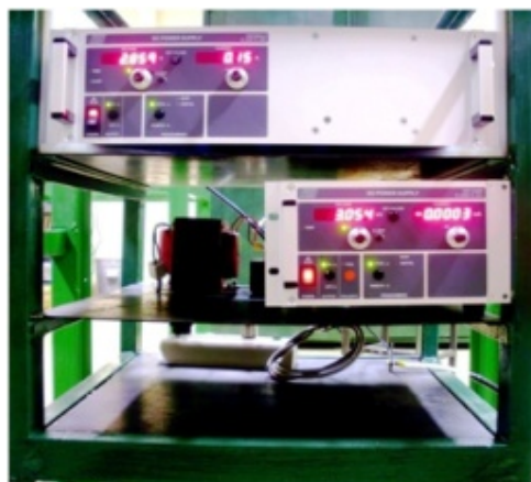
Figura 4.17 Fontes de tensão e de corrente em funcionamento
