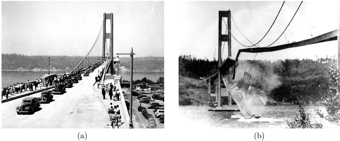
Figura 1 – Ponte de Tacoma: (a) dia da abertura em 1º de julho de 1940 e (b) dia do colapso em 7 de novembro de 1940. Extraído de [1].
