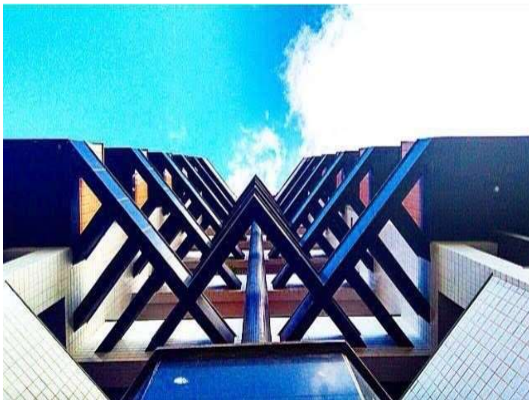
Figura 3 - Fachada Edifício Solar
