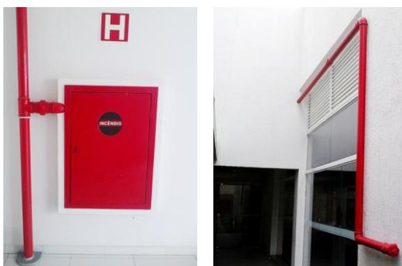
Figura 19: Identificação das tubulações de incêndio pela cor vermelha. Fonte: Autor, 2012.
