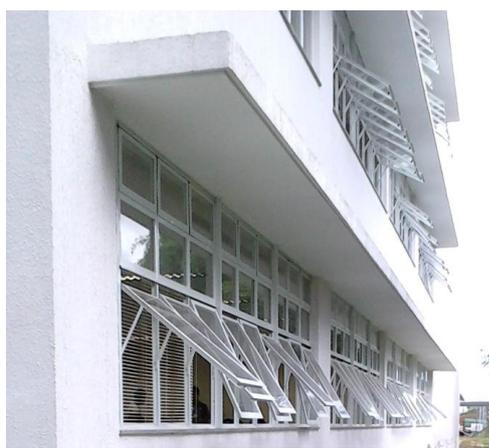
**Figura 18: Proteções solares fixas e janelas com dispositivos de controle de abertura. Fonte: Autor, 2012.**
