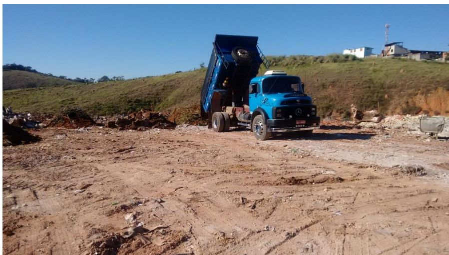
Figura 9- Veículo descarregando os resíduos no local indicado
