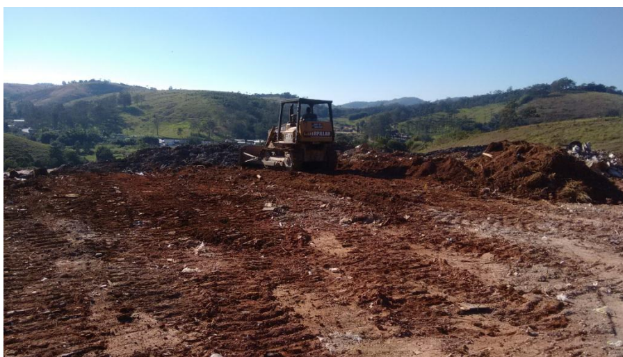
Figura 13– Esteira D4 compactando o material após segregação dos resíduos
