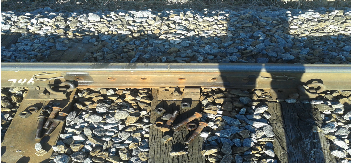
Figura 2.6: União de trilho realizado por junta mecânica.
