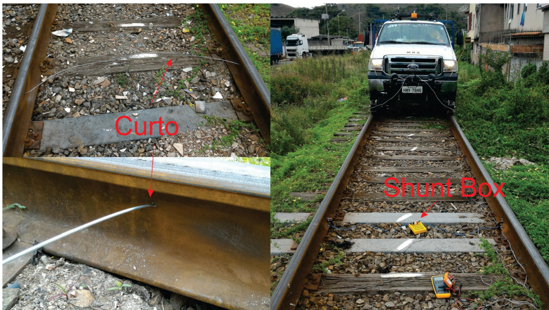
Figura 5.11: Instalação dos pontos de curto na linha.
