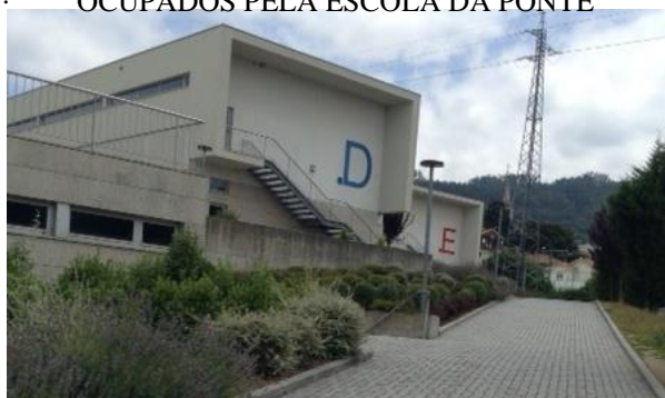
FIGURA 9. PAVILHÕES ‘D’ E ‘E’ OCUPADOS PELA ESCOLA DA PONTE
